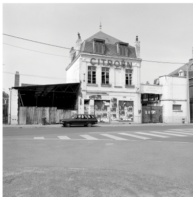
Elévation antérieure, vue du Pont de Beauvais. Phot. Philippe Dapvril IVR31_19885900912X
