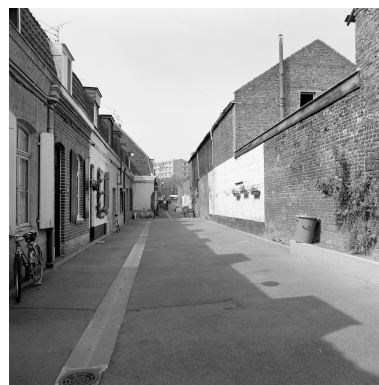
Atelier de fabrication, enfilade rue Roland Garros. Phot. Philippe Dapvril IVR31_19885900913X
