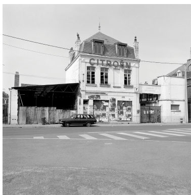
Élévation antérieure, vue du Pont de Beauvais. Phot. Philippe Dapvril IVR31_19885900912X
