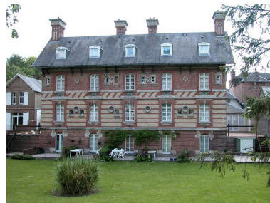
Elévation postérieure, côté digue. Phot. Elisabeth Justome IVR22_20058002852NUCA
