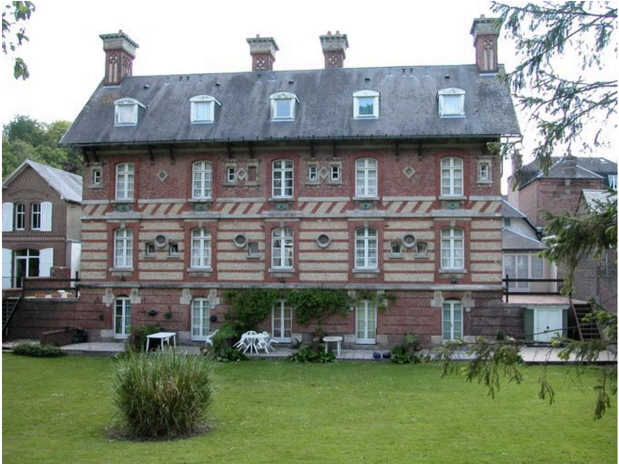
Elévation postérieure, côté digue.
