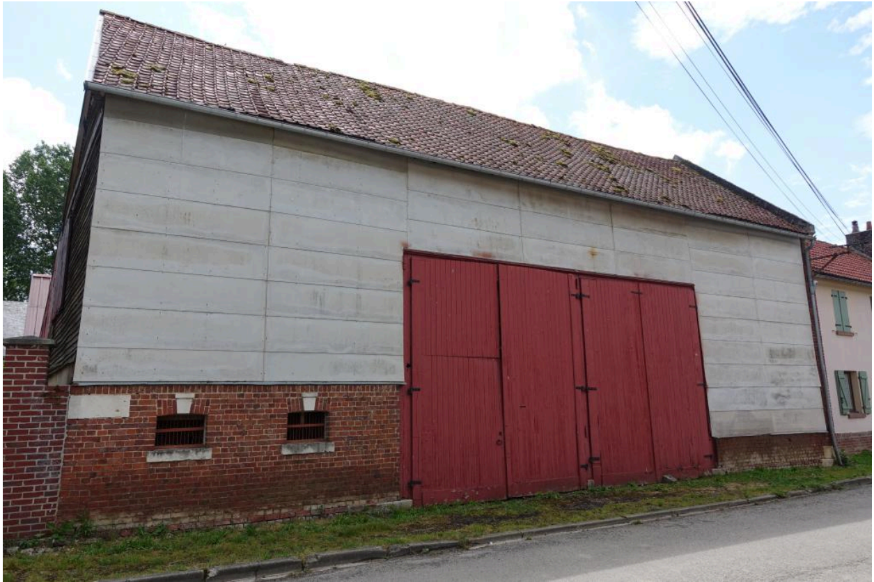
Grange sur rue, n°10, vue depuis l'ouest.
