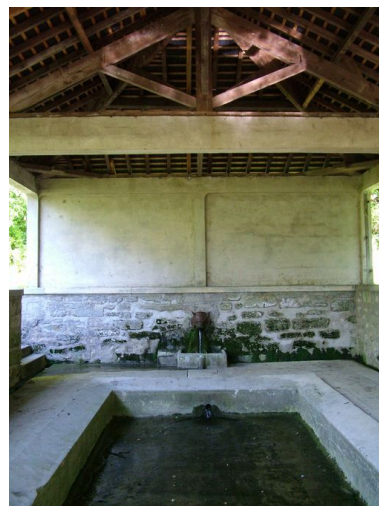
Vue intérieure. Phot. Inès Guérin IVR22_20030202488NUCA
