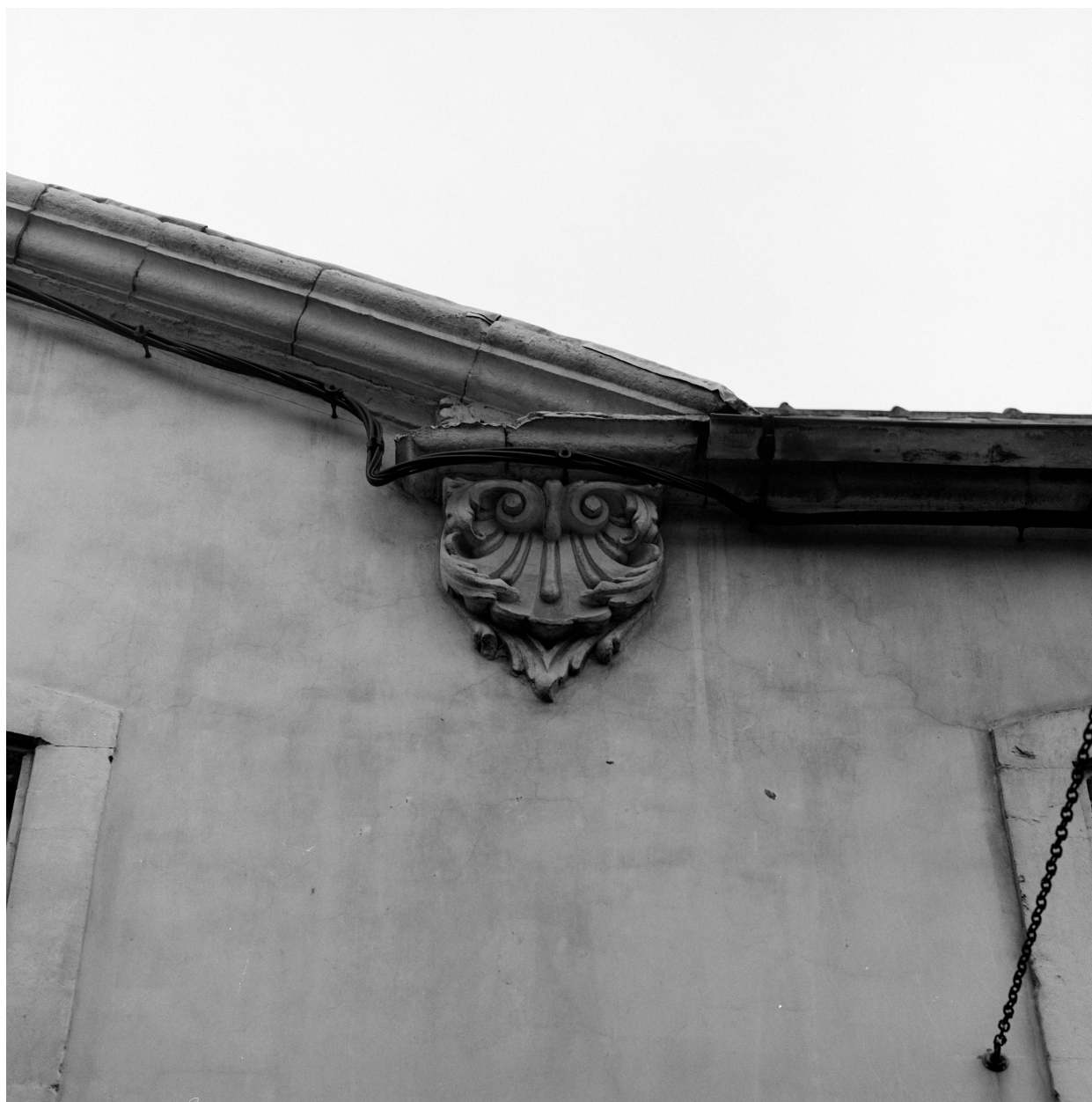
Fronton à base interrompue, console : détail droit.
