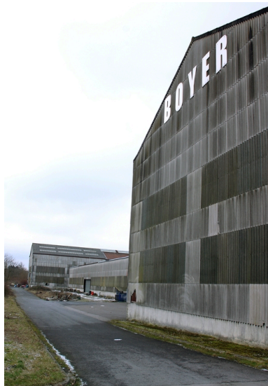
Les ateliers vus depuis le chemin Clastrois. Phot. Frédéric Pillet IVR22_20060205144NUCA
