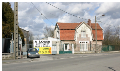
Entrée du site, route de Chauny. Phot. Frédéric Pillet IVR22_20060205141NUCA
