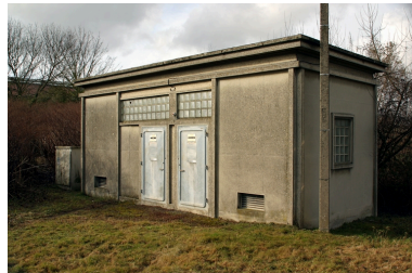
Le transformateur. Phot. Frédéric Pillet IVR22_20060205186NUCA
