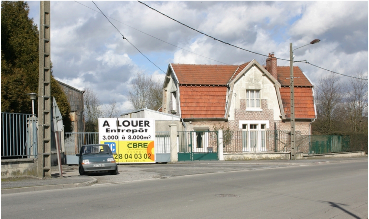
Entrée du site, route de Chauny.
