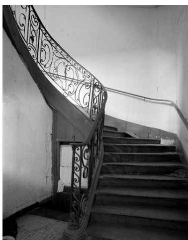
Vue de l'escalier en fer forgé dans la première aile en retour. Phot. Thierry Lefébure IVR22_19960200512V
