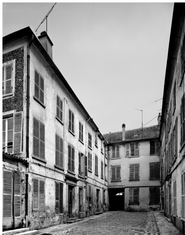
Vue d'ensemble de la cour intérieure. Phot. Thierry Lefébure IVR22_19940202678XA
