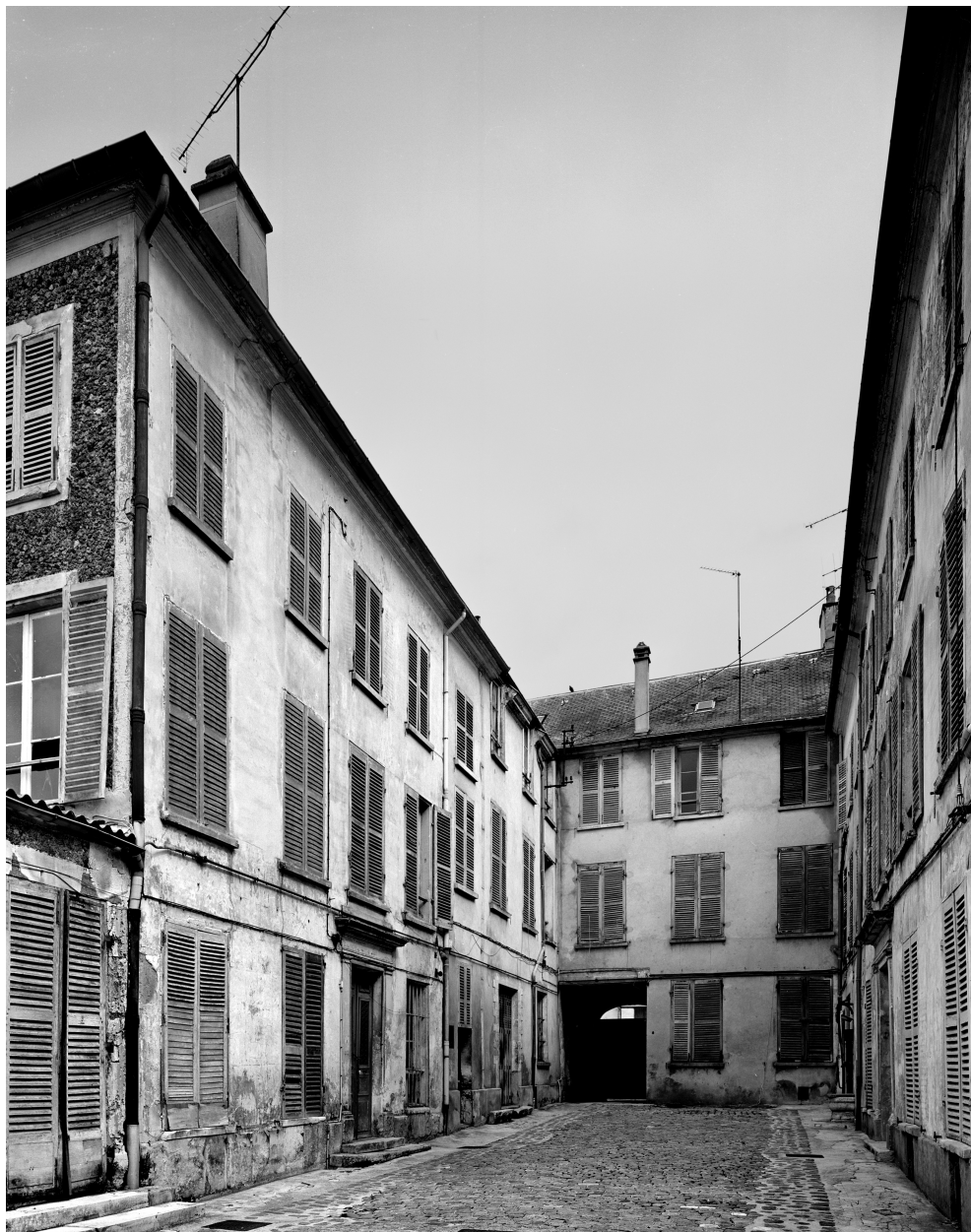
Vue d'ensemble de la cour intérieure.
