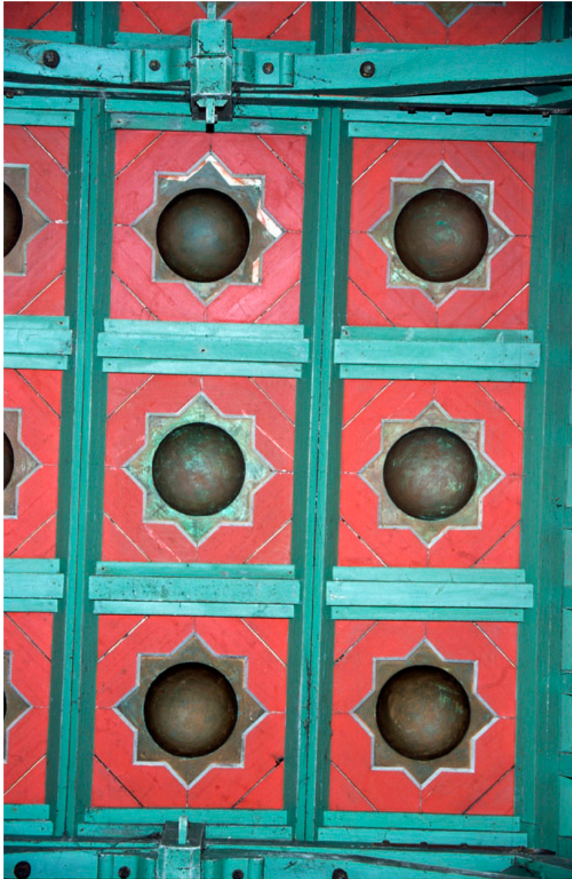
Détail des caissons du plafond avec leur motif étoilé.
