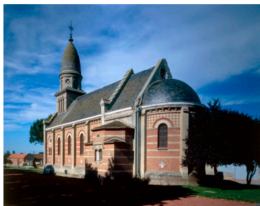
Vue sur le chevet. Phot. Irwin Leullier IVR22_19988000732VA
