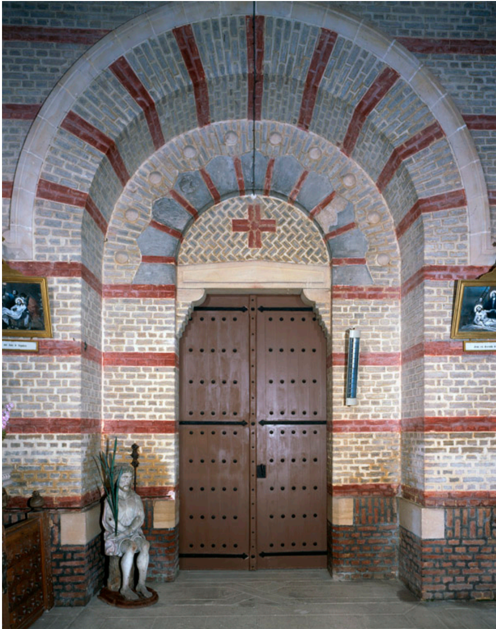
Vue intérieure : la porte menant à la sacristie orientale.
