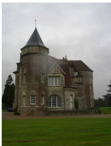
Vue latérale occidentale. Phot. Inès Guérin IVR22_20068005594NUCA
