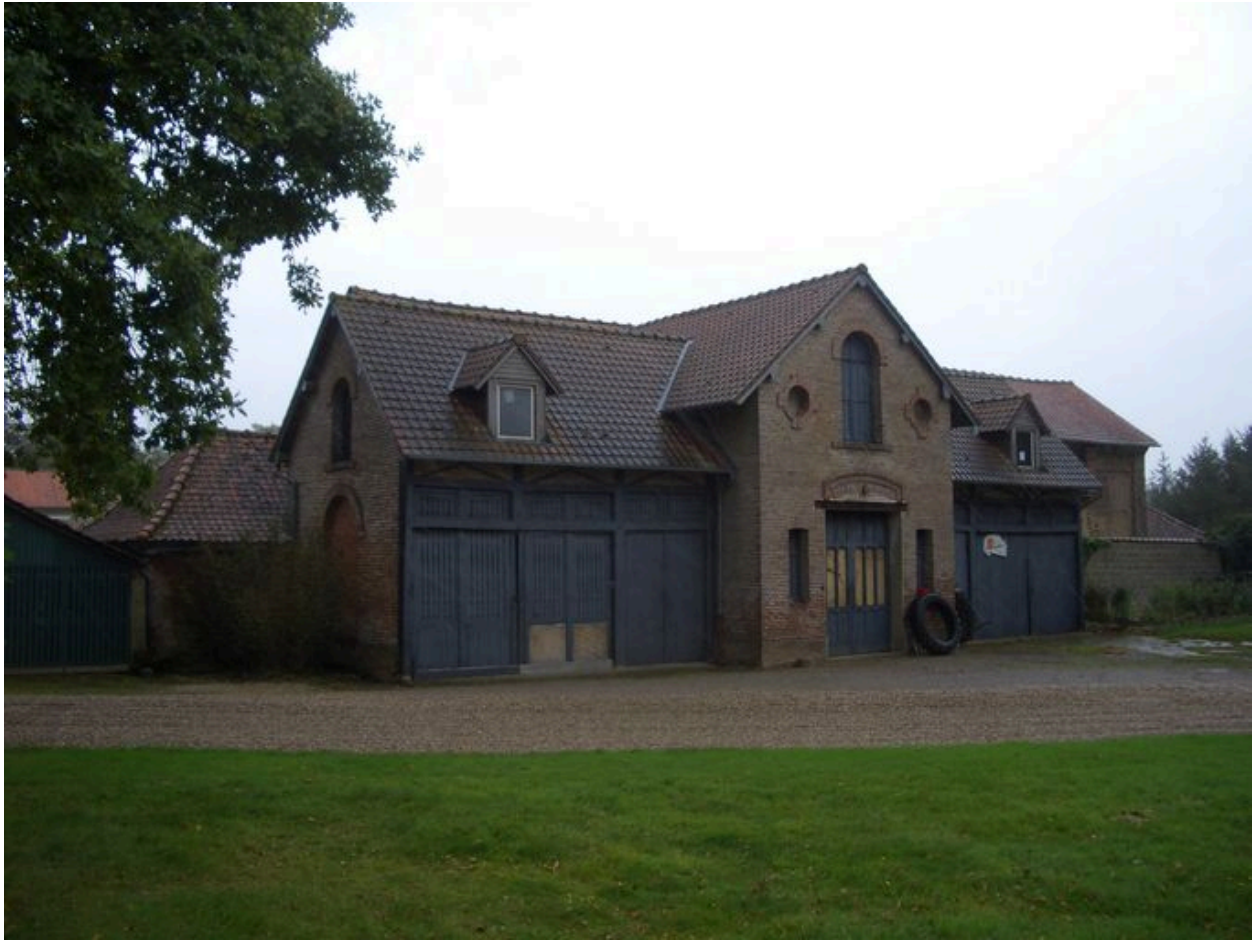
Vue des dépendances du château.
