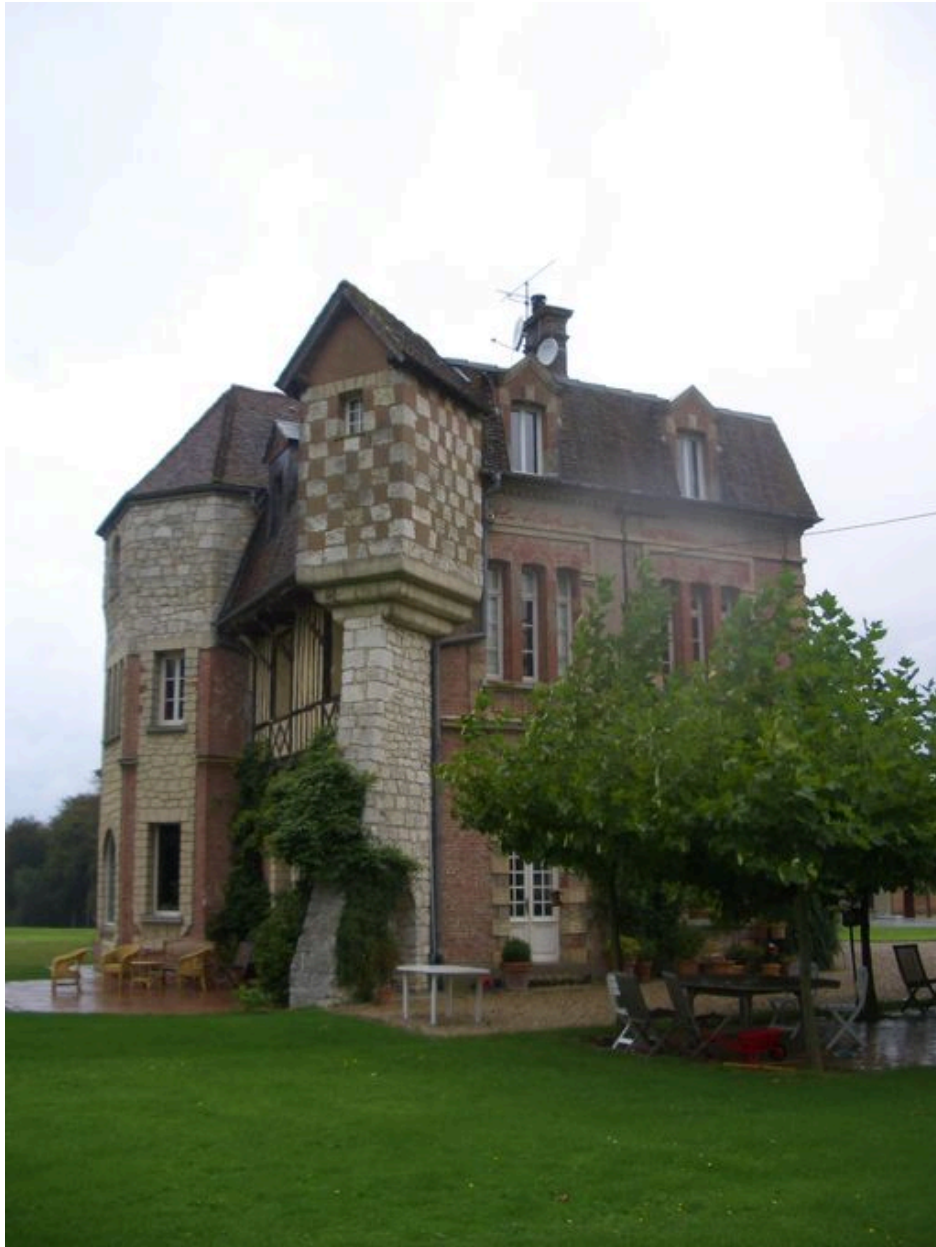
Vue latérale de la façade orientale.
