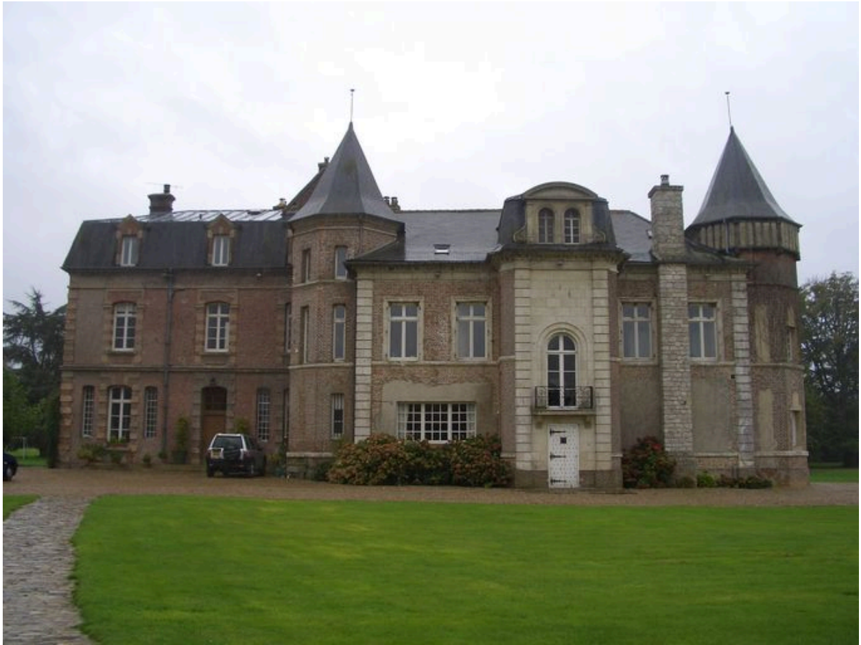
Vue générale depuis le nord.
