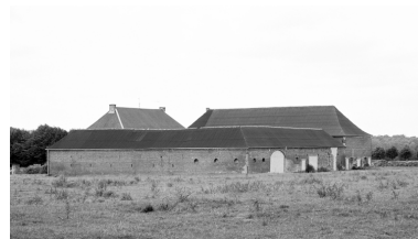
Vue générale de la ferme depuis le nord-est. Phot. Thierry Lefébure IVR22_19960200603X
