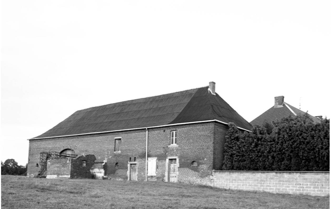
Vue externe du bâtiment ouest à usage de logement et étable.
