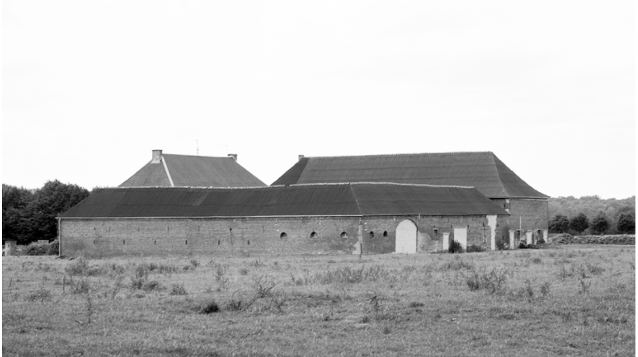
Vue générale de la ferme depuis le nord-est.
