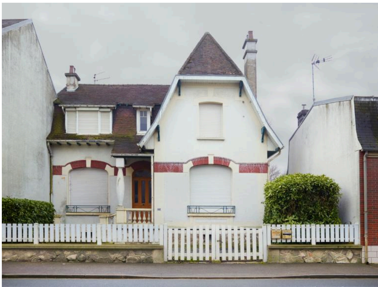
Maison, n° 25 rue du faubourg de Péronne. Vue de la façade principale. Maison construite par Paul Auger en 1929 pour M. Prosper Bouchez. Plan en L, avec fonton-pignon couvert par une croupe, en retrait avec mur bahut en fausse meulière.
