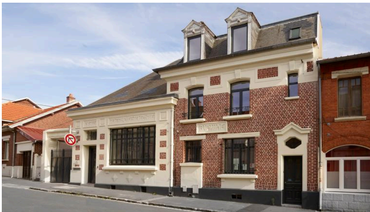
Poste et habitation du receveur, rue Jean-Baptiste-Lequette. Construits par Eugène Bidard en 1925.
