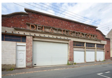
Entrepôt et commerce de bois et de quincaillerie. Vue de la façade principale. Construits en 1920 rue de l'Amiral Payen par René Trubert pour M. Delattre. Phot. Hubert Bouvet IVR32_20196200501NUCA
