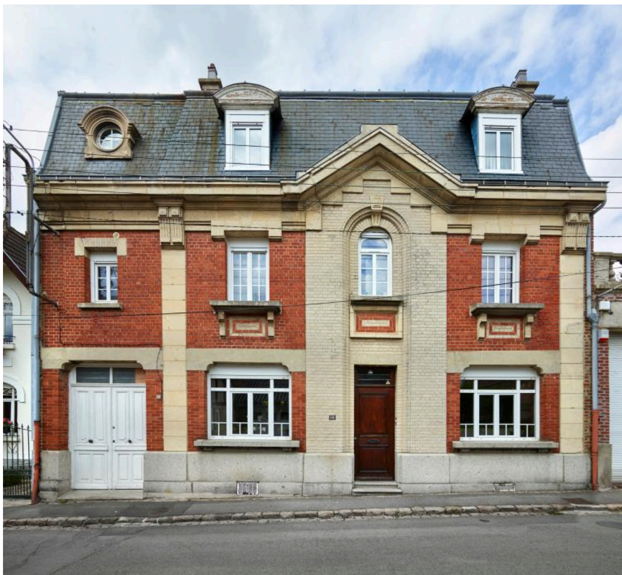
Maison, n° 16 rue de l'amiral Payen. Vue de la façade principale. La travée centrale en brique blanche est surmontée d'un petit pignon triangulaire, la toiture débordante repose sur une large corniche en pierre, et les lucarnes sont couronnées d'un fronton en demi-lune. Dernière travée surmontée d'un oeil de boeuf.
