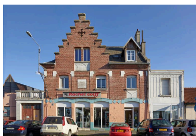
Maison n° 1 rue de la gare. Vue de face. Façade couronnée d'un pignon à redents. Ancienne maison-estaminet de Mme Veuve Decomble-Lainé, construite par Eugène Bidard en 1921 (AD Pas de Calais, 10R9/68). Phot. Hubert Bouvet IVR32_20196200516NUCA
