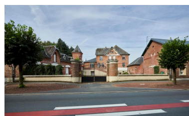
Ferme, n° 65 rue du faubourg de Péronne. Vue générale depuis la rue. Ferme sur cour avec maison d'habitation en fond de cour. Construite par Eugène Bidard pour M. Vasseur entre 1920 et 1923.
