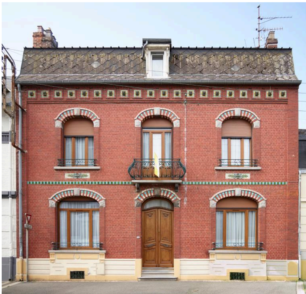
Maison, n°8 rue Lecointe. Façade principale depuis la rue. Décors de briques vernissées, de plaques émaillées et de cabochons émaillés.
