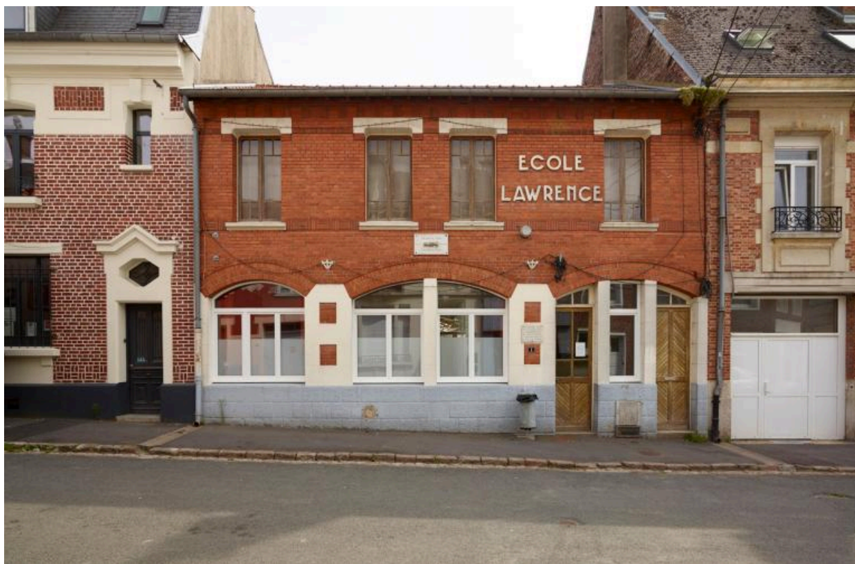
Ecole lawrence, rue Jean-Baptiste-Lequette. Construite en 1939.
