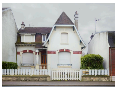
Maison, n° 25 rue du faubourg de Péronne. Vue de la façade principale. Maison construite par Paul Auger en 1929 pour M. Prosper Bouchez. Plan en L, avec fonton-pignon couvert par une croupe, en retrait avec mur bahut en fausse meulière. Phot. Hubert Bouvet IVR32_20196200865NUCA
