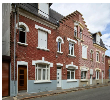
Maison à 4 unités d'habitation, n° 4-6-8-10 rue de l'amiral Payen. Construite en 1924 par François Clermont pour Mme Caroline Daumas (AD Pas de Calais, 10R9/57, dossier n°819). Vue de la façade principale, où la partie centrale réunit deux logements sous un pignon en "pas de moineaux". Phot. Hubert Bouvet IVR32_20196200496NUCA
