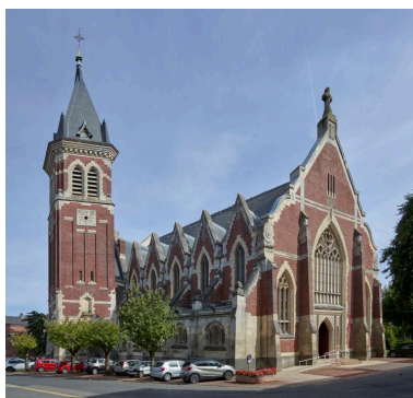
Eglise paroissiale Saint- Nicolas. Construite par Eugène Bidard entre 1923 et 1931. Phot. Hubert Bouvet IVR32_20196200378NUCA
