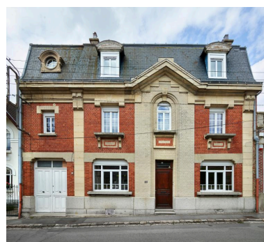
Maison, n° 16 rue de l'amiral Payen. Vue de la façade principale. La travée centrale en brique blanche est surmontée d'un petit pignon triangulaire, la toiture débordante repose sur une large corniche en pierre, et les lucarnes sont couronnées d'un fronton en demi-lune. Dernière travée surmontée d'un oeil de boeuf. Phot. Hubert Bouvet IVR32_20196200500NUCA
