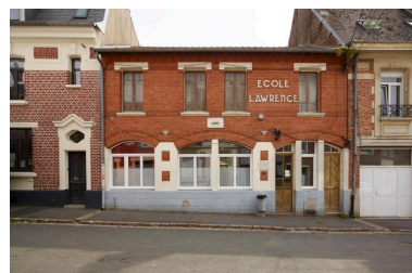
Ecole Lawrence, rue Jean-Baptiste-Lequette. Construite en 1939.
