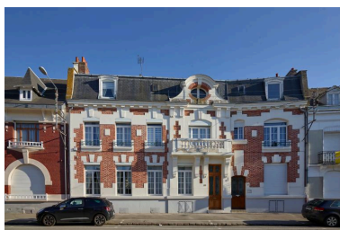
Maison, n° 16-18 rue Marcellin- Gaudefroy. Façade sur rue. Ancienne maison du docteur Baude, construite en 1922 par Eugène Bidard.
