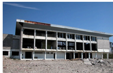
Le casino de 1966 en cours de démolition, mars 2005. Phot. Elisabeth Justome IVR22_20058003774NUCA
