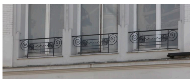
Décor en spirales des garde-corps. Phot. Pierre Thibaut IVR31_20096200259NUCA
