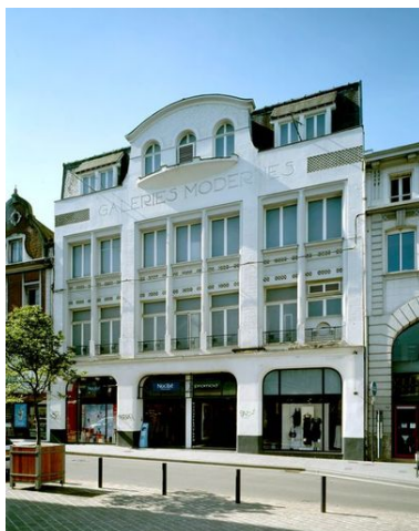
Vue générale. Phot. Pierre Thibaut IVR31_20086200216VA
