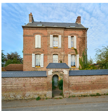
Ancien presbytère, depuis l'est.
