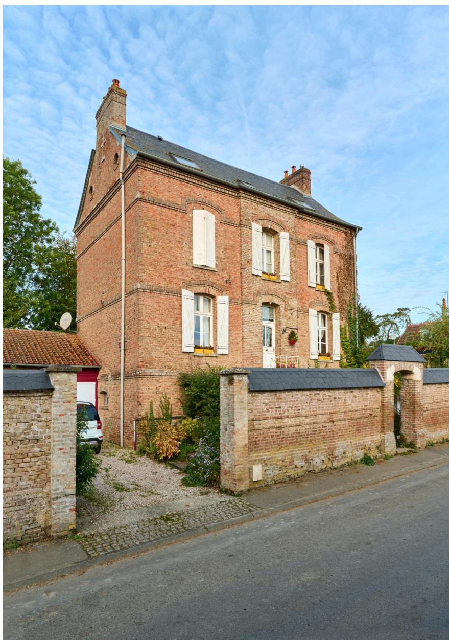
Ancien presbytère, depuis le sud-est.
