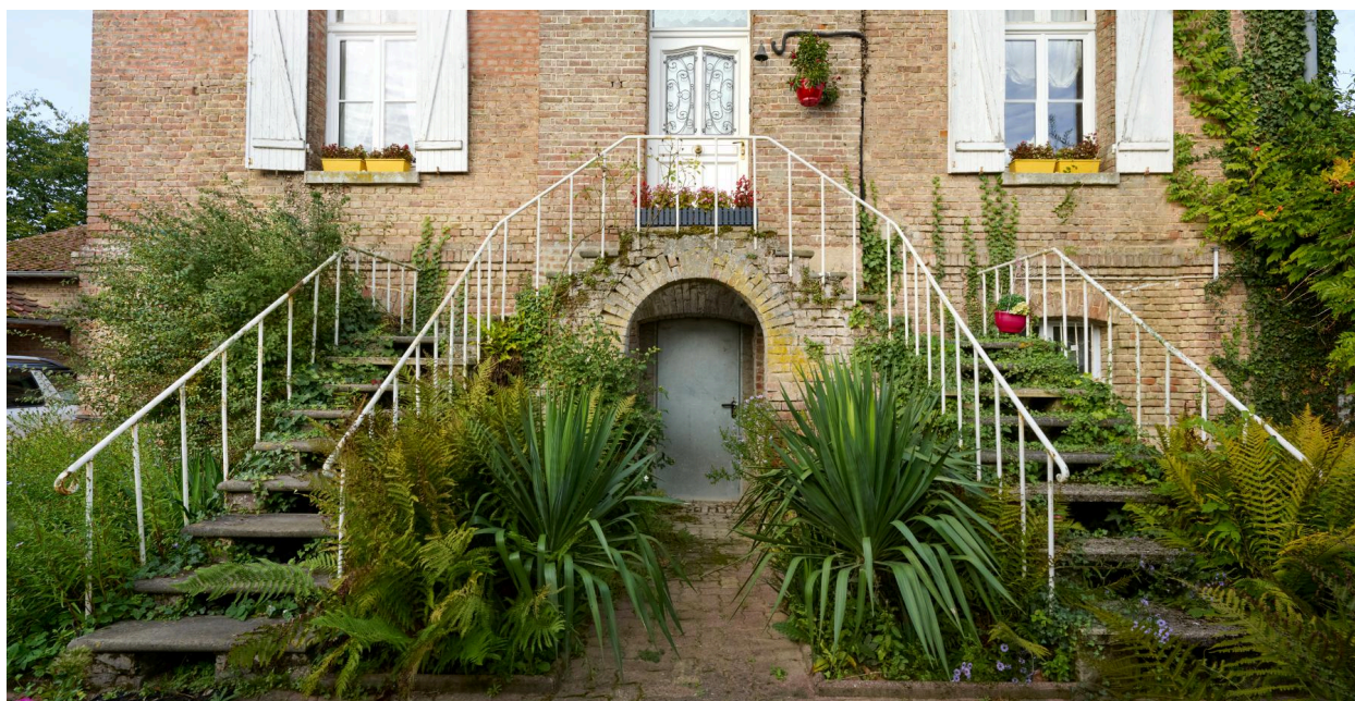
Escalier d'accès de l'ancien presbytère, depuis l'est.
