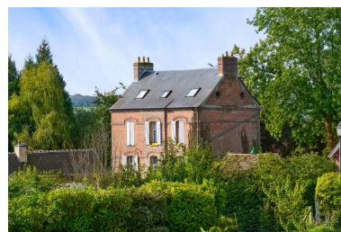
Vue nord-est de l'ancien presbytère depuis l'escalier d'accès à la tribune de l'église Saint-Martin.
