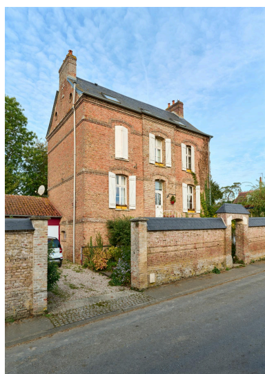
Ancien presbytère, depuis le sud-est.
