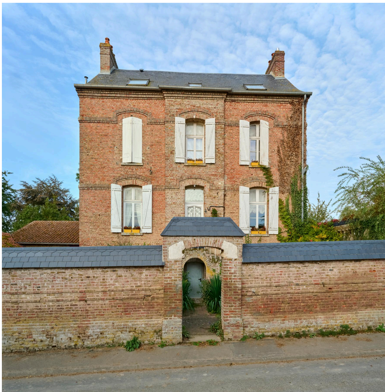
Ancien presbytère, depuis l'est.
