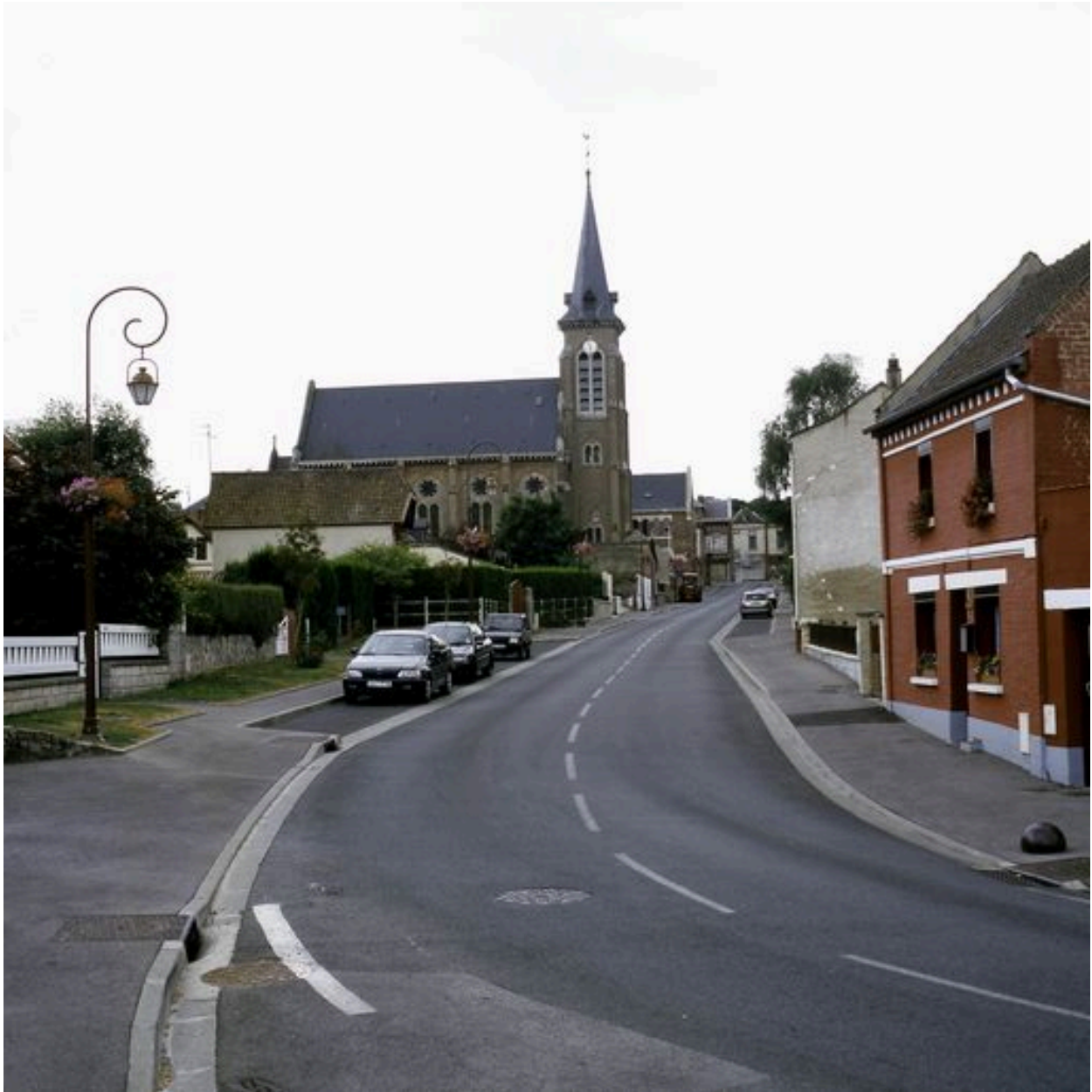
Vue de situation depuis le nord.
