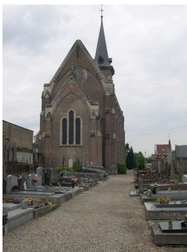
Vue depuis le nord-ouest. Phot. Isabelle Barbedor IVR22_20068010000NUCA
