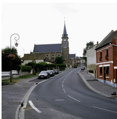
Vue de situation depuis le nord. Phot. Thierry Lefébure IVR22_20038000874XA
