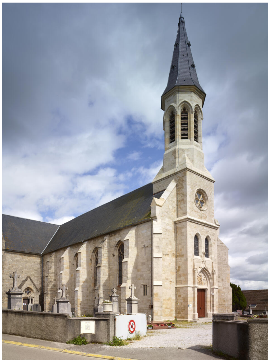
Vue du clocher et de l'élévation nord.
