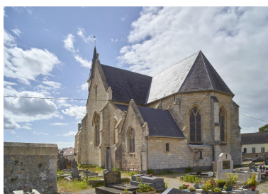
Vue du chevet depuis le sud-est. Phot. Pierre Thibaut IVR32_20246200186NUCA
