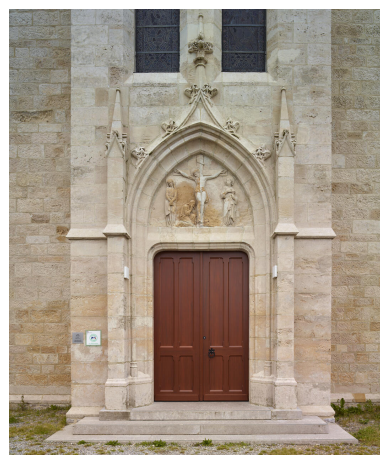
Vue de l'entrée. Phot. Pierre Thibaut IVR32_20246200189NUCA
