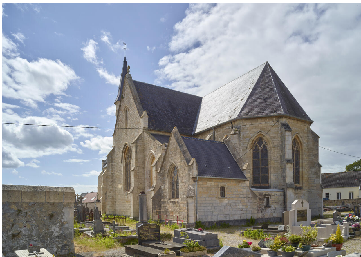
Vue du chevet depuis le sud-est.
