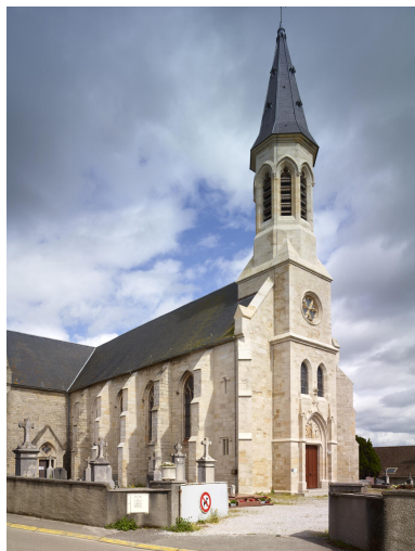
Vue du clocher et de l'élévation nord.
