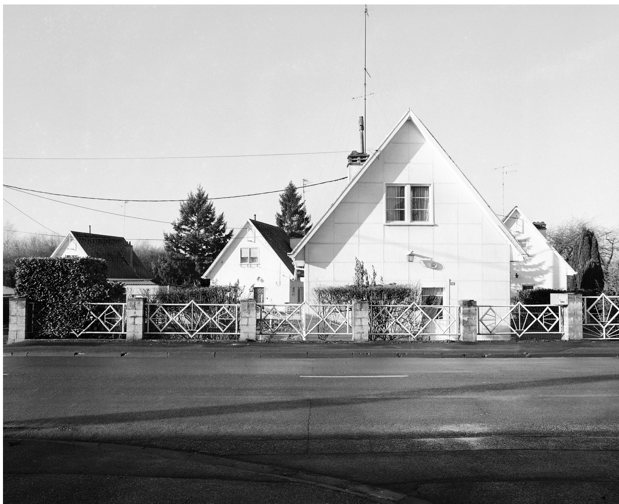
Vue générale partielle de l'ensemble.
