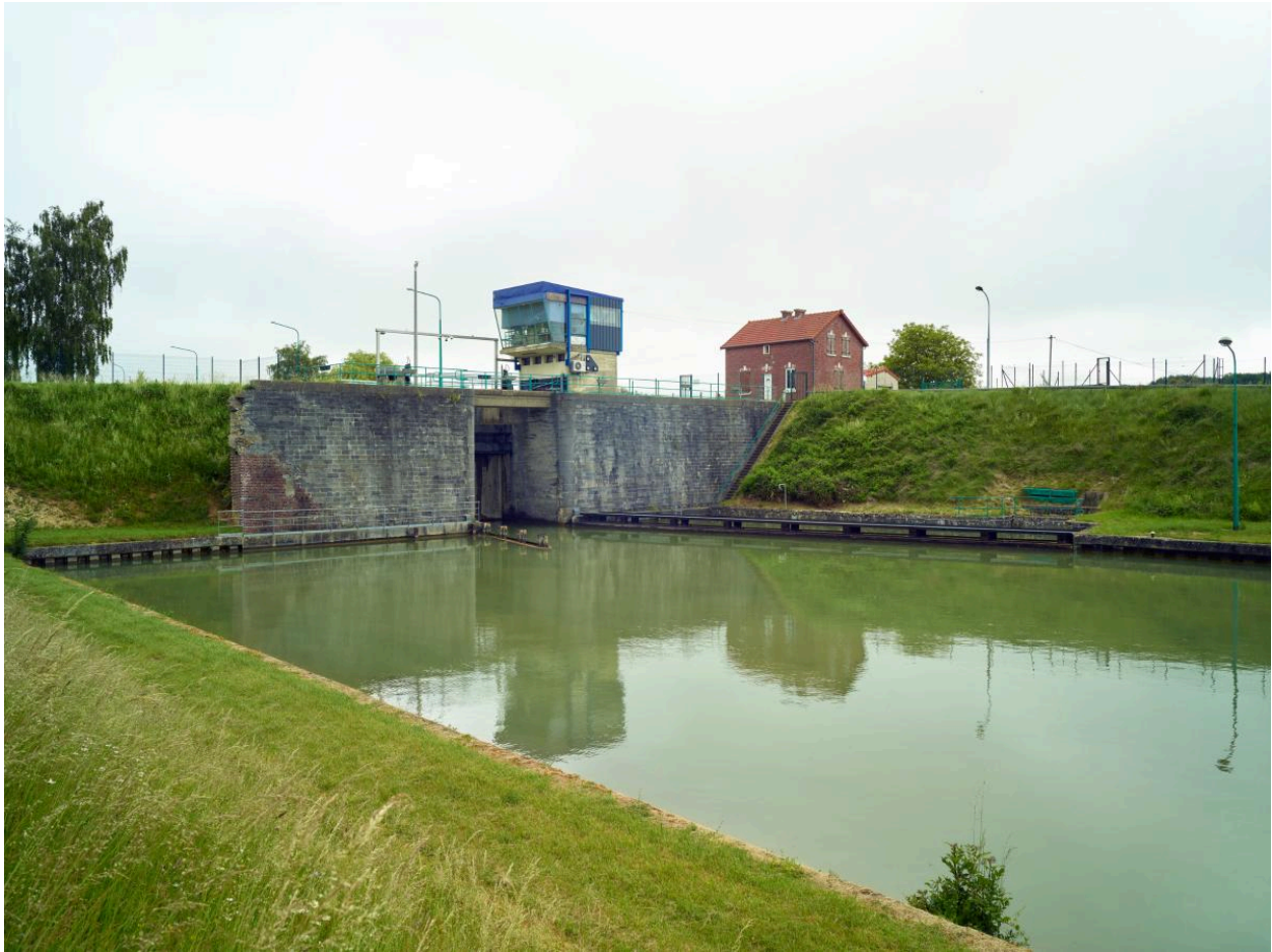
Tête aval du site : poste de commande et maison de service.
