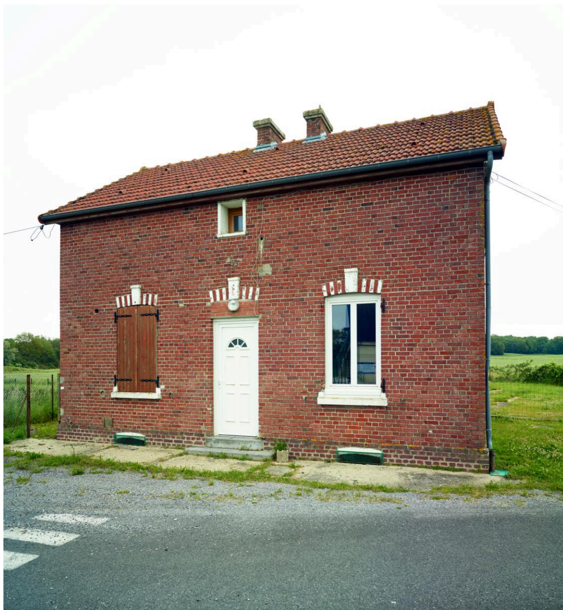
La maison de service (amont).
