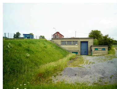
La station de pompage. Phot. Pierre Thibaut
