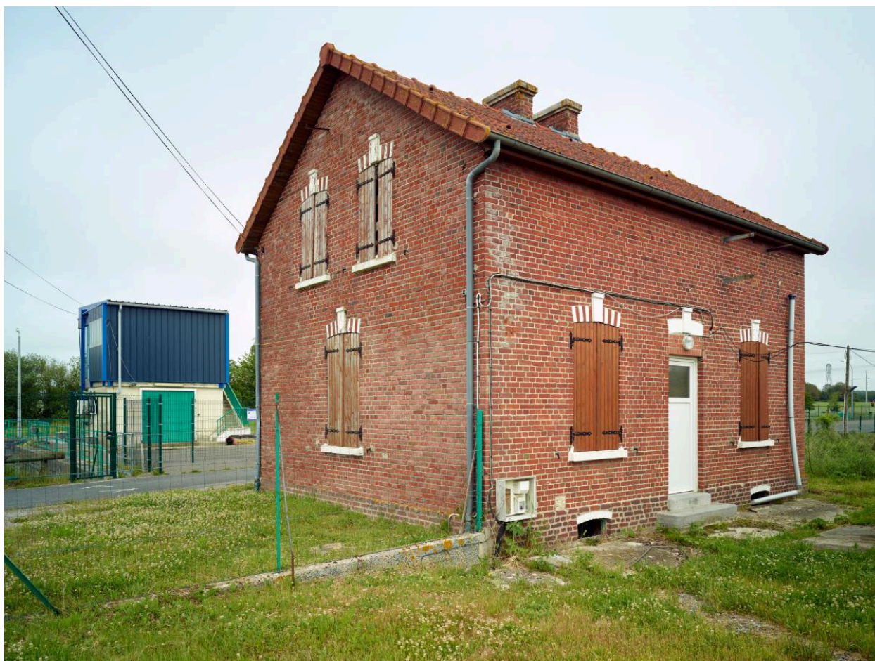
La maison de service (aval).
