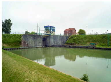
Tête aval du site : poste de commande et maison de service. Phot. Pierre Thibaut IVR32_20216000815NUCA
