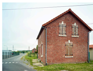
La maison de service (aval).
