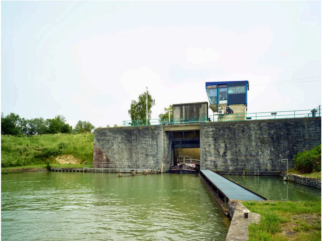
Tête aval de l'écluse : poste de commande et porte levante.
