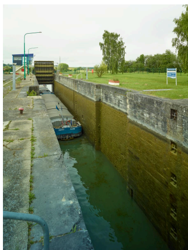
Péniche qui entre dans le sas de l'écluse par la porte levante. Phot. Pierre Thibaut IVR32_20216000811NUCA
