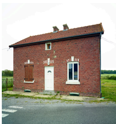
La maison de service (amont).
