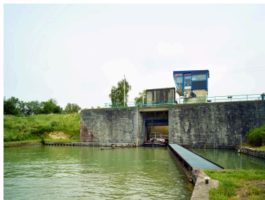
Tête aval de l'écluse : poste de commande et porte levante. Phot. Pierre Thibaut IVR32_20216000824NUCA
