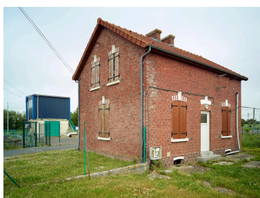
La maison de service (aval).
