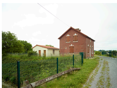
La maison de service (aval).
