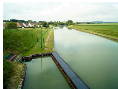
Le bassin de tranquillisation en aval du site.
