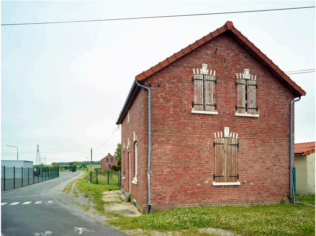
La maison de service (aval).
