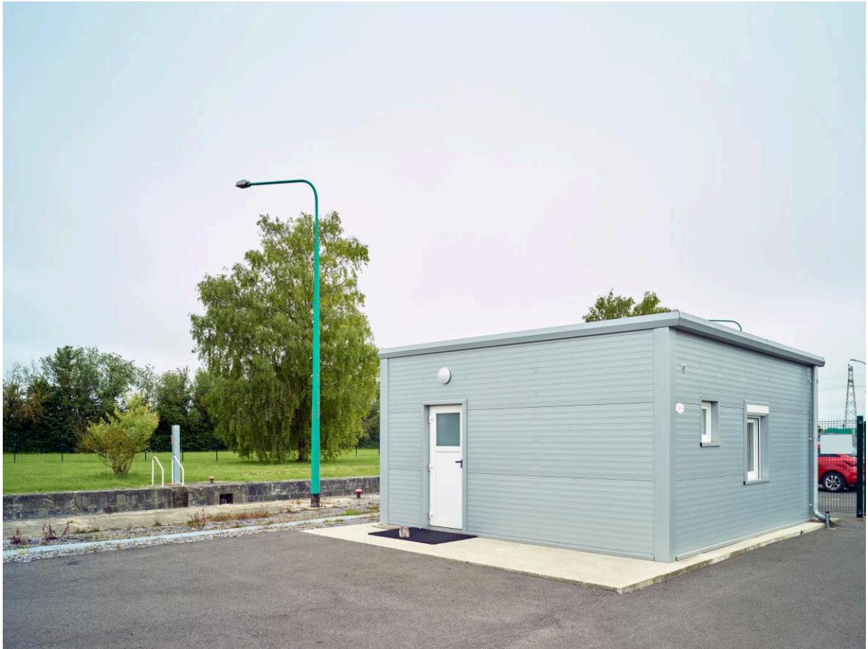
Le nouveau poste de commande.
