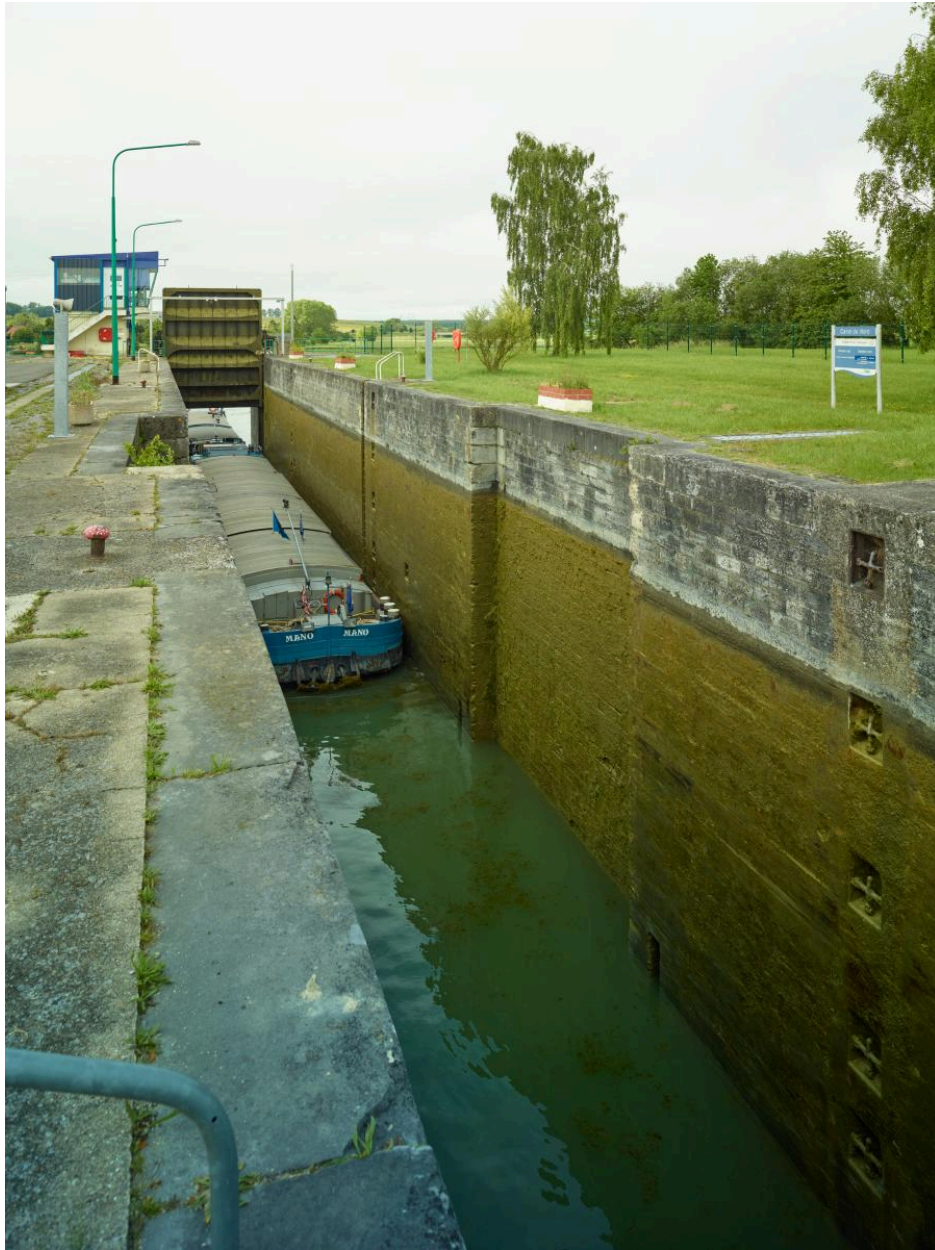
Péniche qui entre dans le sas de l'écluse par la porte levante.
