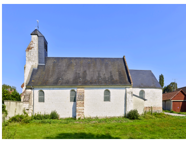
Vue de l'élévation sud. Phot. Thierry Lefébure IVR32_20248001199NUCA
