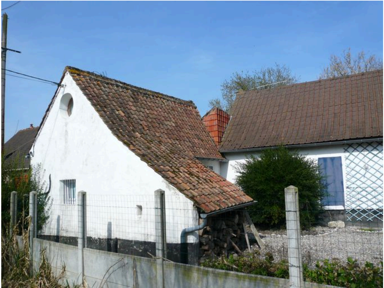
Vue du bâtiment à l'ouest.
