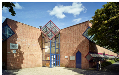
L'entrée et la façade sur la rue Vermeer. Phot. Pierre Thibaut IVR32_20195901002NUCA
