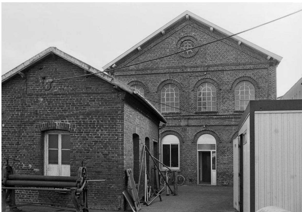
Atelier de fabrication, flanc nord.
