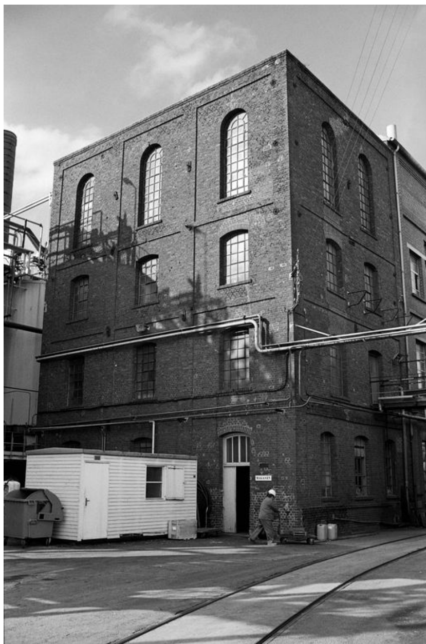
Atelier de fabrication, flanc sud.
