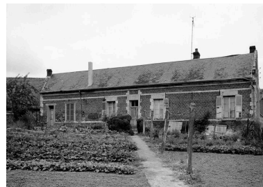
Logis. Elévation postérieure. Phot. Jean-Michel Périn IVR22_19856001003X
