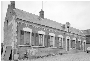
Logis. Elévation antérieure. Phot. Jean-Michel Périn IVR22_19856001004X
