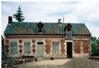
Logis. Elévation antérieure. Phot. Michel Hérold IVR22_19856000936ZA
