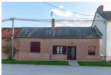
Ancien commerce, n°29 Grande Rue, vue depuis le nord. Phot. Marc Kérignard IVR32_20226000052NUCA
