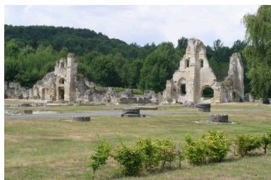
Vue du bâtiment des convers. Phot. Inès Guérin IVR22_20030202058NUCA
