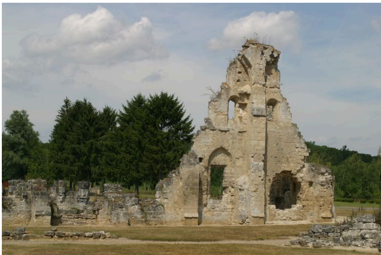
Vue partielle du bâtiments des convers.
