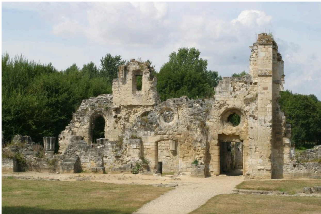
Vue partielle du bâtiments des convers.
