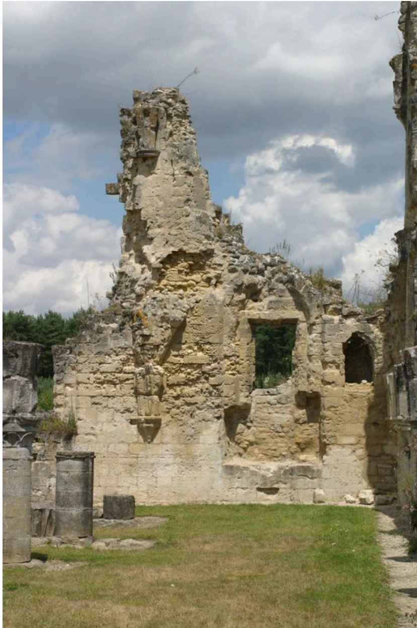
Vue partielle de la salle du chapitre.
