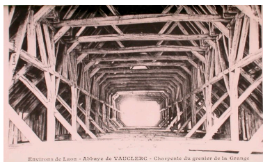
Vue ancienne de la charpente du grenier de la grange (AD Aisne : 2 Fi Bouconville-Vauclair 40). Repro. Inès Guérin IVR22_20030202063NUCAB
