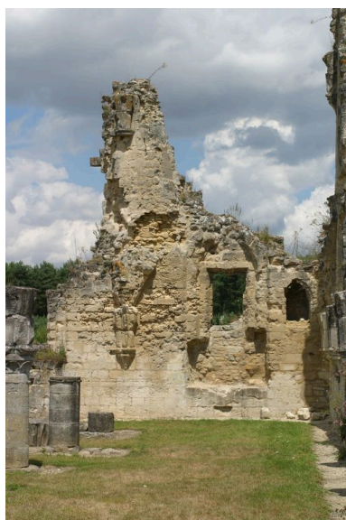
Vue partielle de la salle du chapitre. Phot. Inès Guérin IVR22_20030202059NUCA
