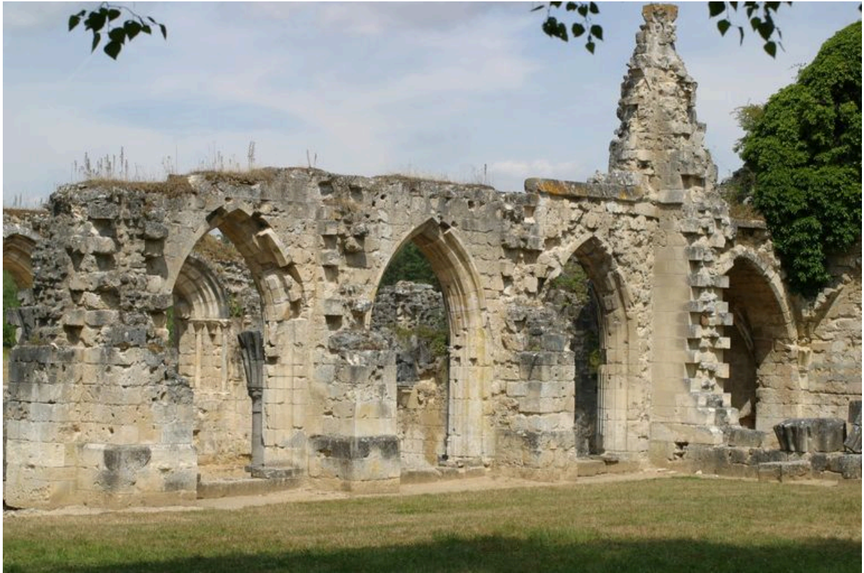
Vue partielle de la salle du chapitre.
