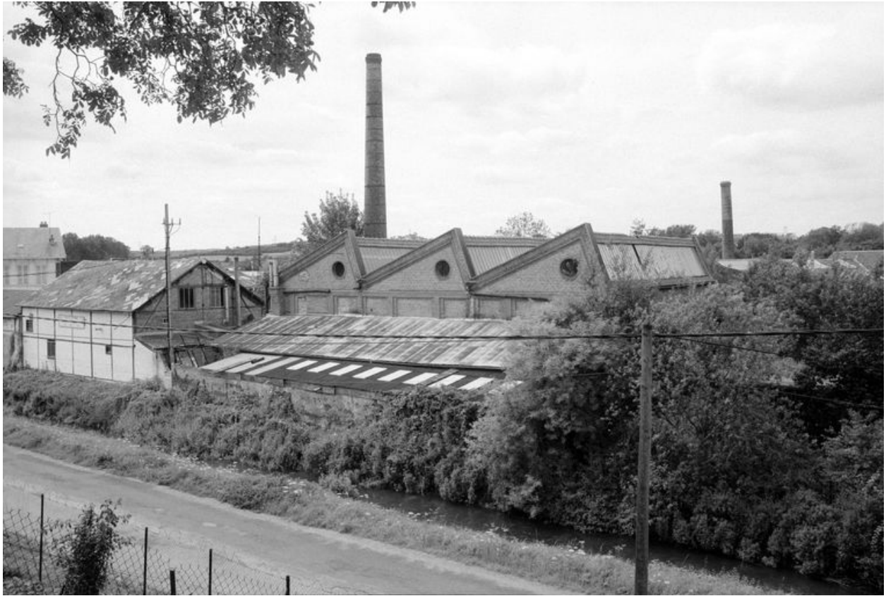
Vue partielle, flanc sud-est.
