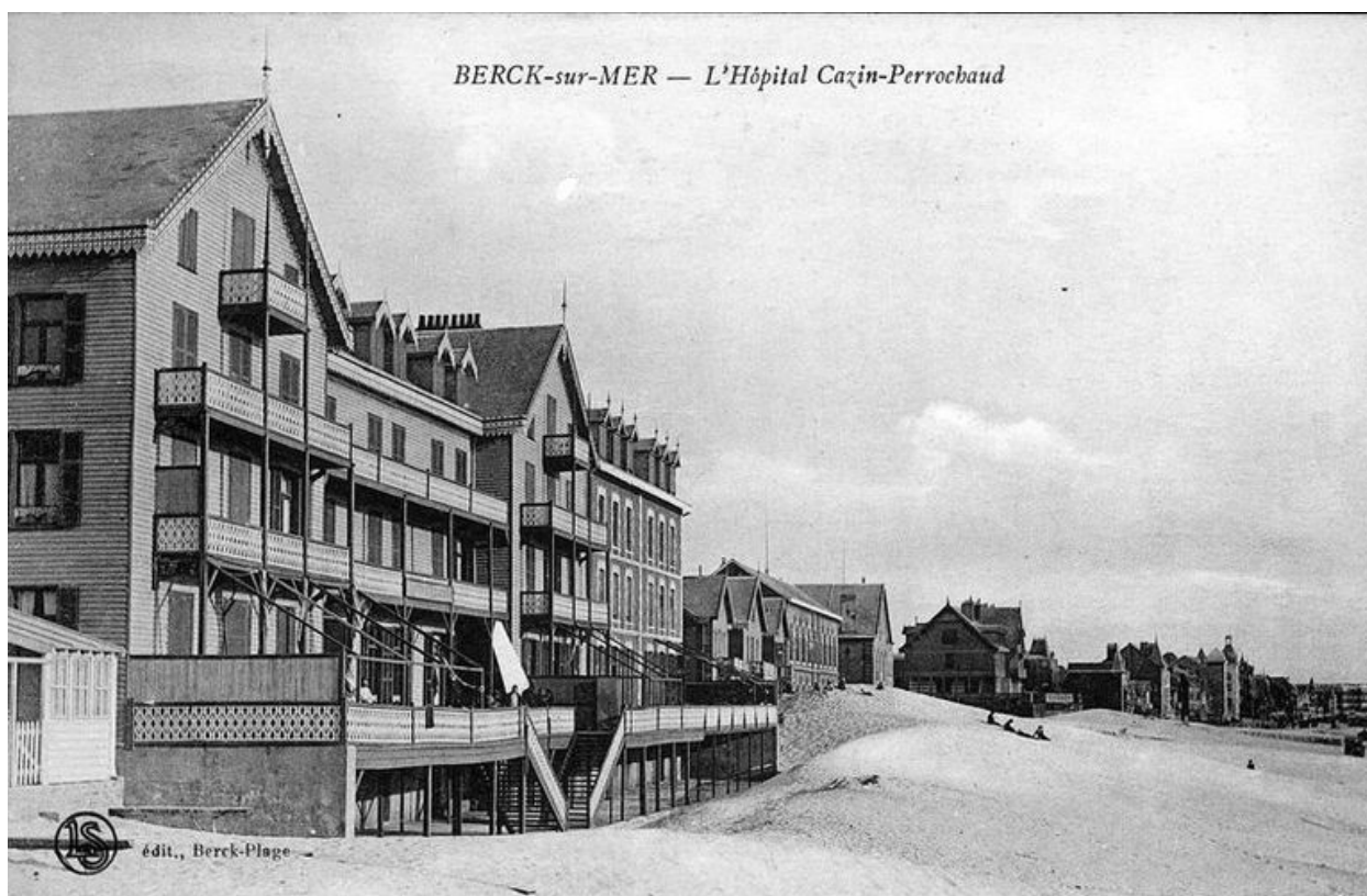
Elévation antérieure, état avant la suppression des balcons et terrasses en charpente du bâtiment de l'ancien Grand-hôtel, vue de trois-quarts gauche. Carte postale, 1er quart 20e siècle (coll. part.).
