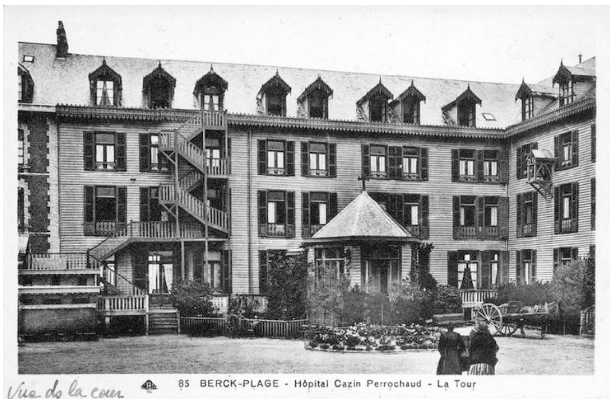
Elévation postérieure du corps de logis principal, détail de la partie droite construite en bois correspondant à l'ancien Grand Hôtel, et extrémité proximale de l'aile nord. Carte postale, 1er quart 20e siècle (coll. part.).
