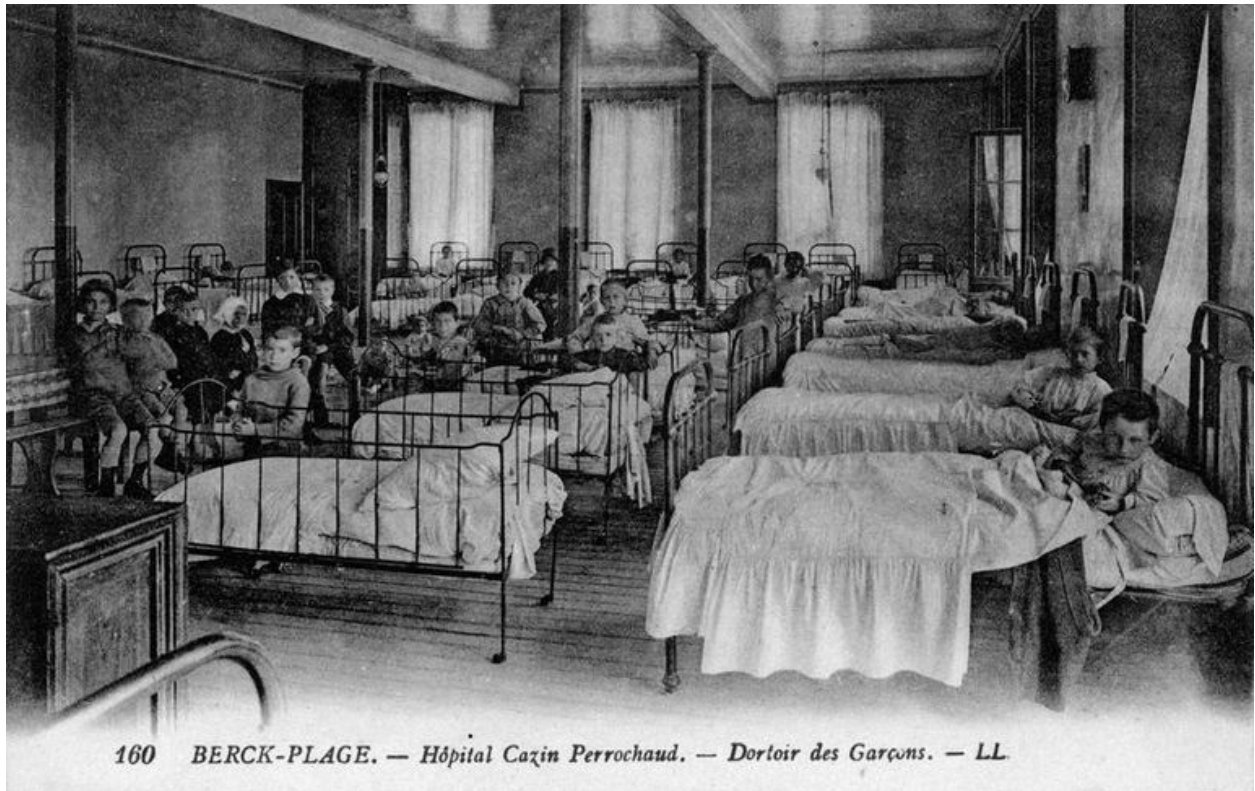
Dortoir des garçons, vue générale. Carte postale, 1er quart 20e siècle (coll. part.).
