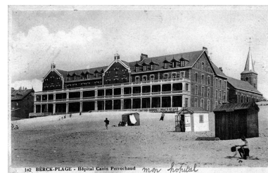
Élévation sur la plage, état après la construction des galeries de cure en béton armé, vue générale prise de trois-quarts droit. Carte postale, vers 1925 (coll. part.). Phot. Thibaut Pierre (reproduction) IVR31_20066200459NUC
