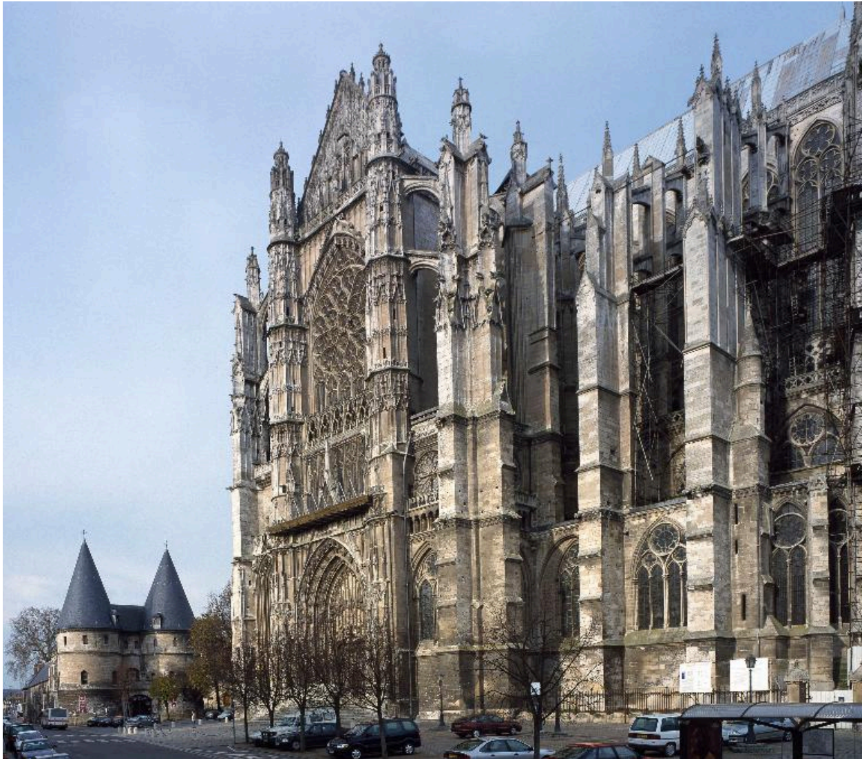
Vue du flanc sud, avec les deux tours du palais épiscopal.
