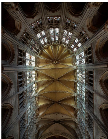
Vue des voûtes du choeur.
