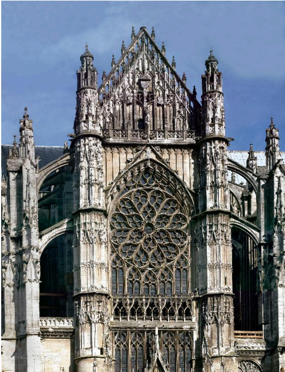
Vue de la façade sud du transept : partie supérieure (claire-voie, rose, gâble).
