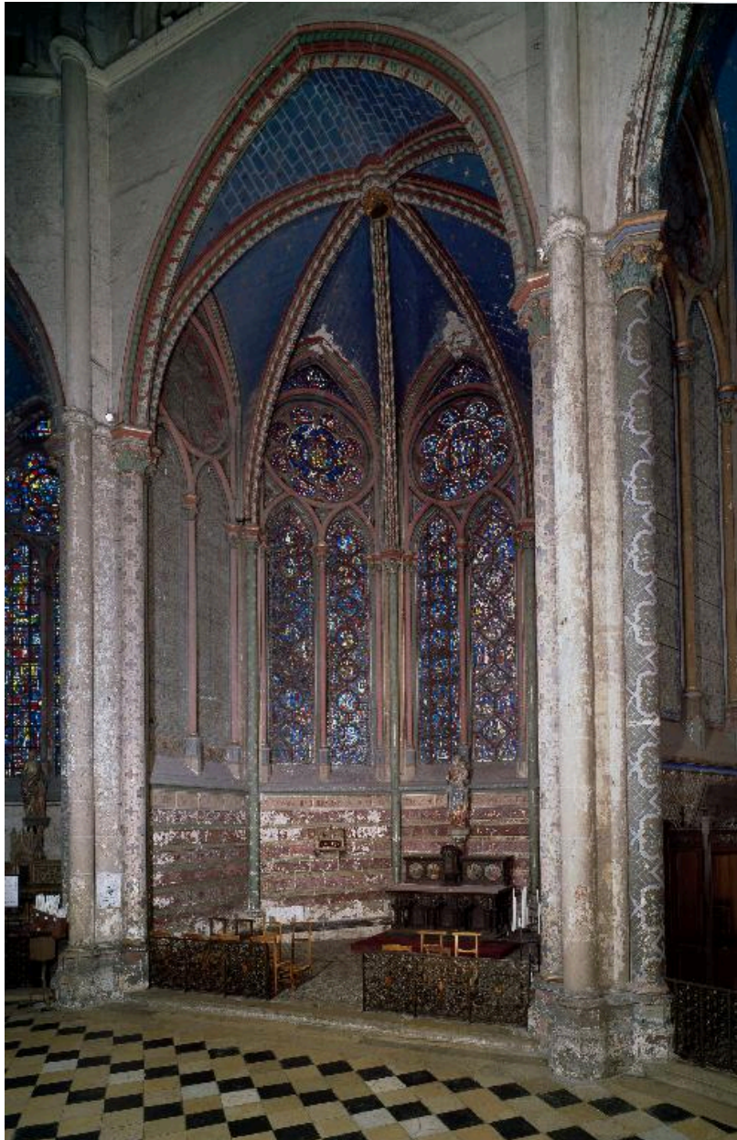
Vue intérieure de la chapelle axiale.
