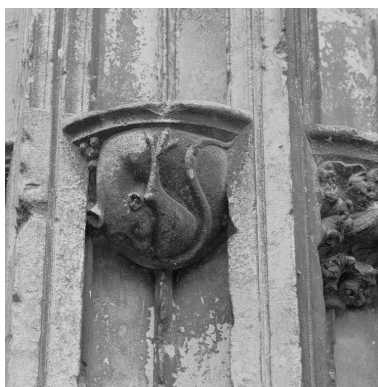
Détail du portail nord : console sculptée du trumeau. Phot. Thierry Lefébure IVR22_19996001698X
