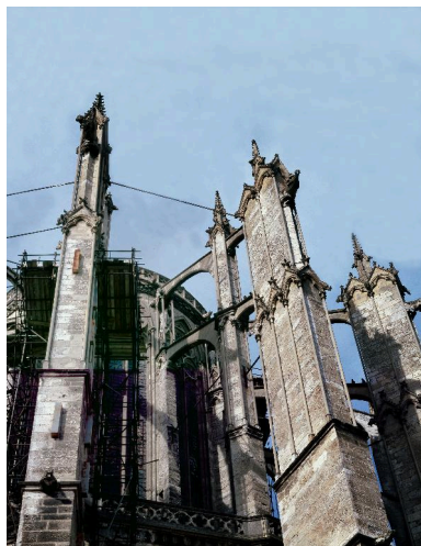
Vue des arcs-boutants du chevet. Phot. Thierry Lefébure IVR22_19976000012VA
