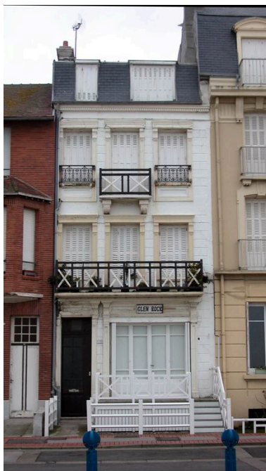
Vue d'ensemble de la maison dite Glen Rock, depuis l'esplanade. Phot. Elisabeth Justome IVR22_20038005316NUCA
