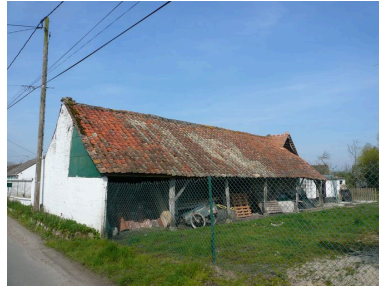
Vue postérieure des étables. Phot. Inès Guérin IVR22_20078005760NUCA
