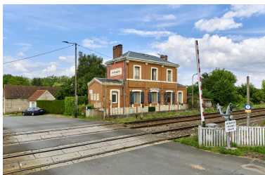
Vue de la gare et du passage à niveau depuis le sud-ouest. Phot. Thierry Lefébure IVR32_20238000548NUCA
