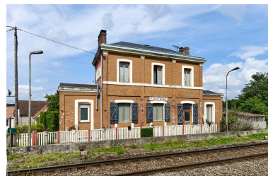
Vue sud de la gare. Phot. Thierry Lefébure IVR32_20238000549NUCA
