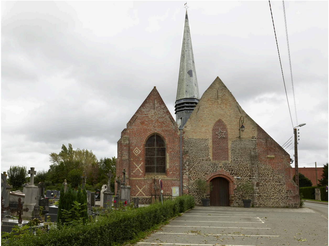
Façade principale de l'église Saint-Omer.
