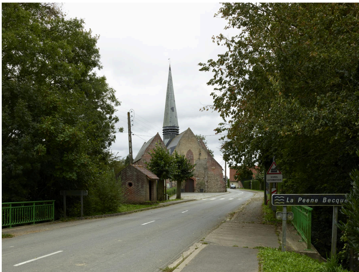
Vue de l'église dans son contexte générale depuis le pont de la Peene Becque.
