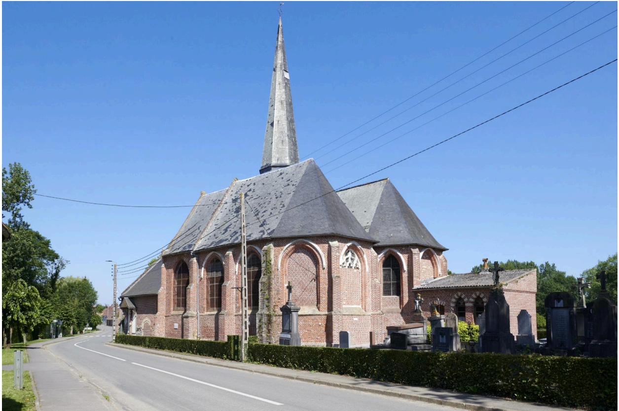
Vue de l'église depuis la rue Principale.
