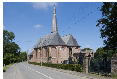
Bas-côté sud, depuis la route. Phot. Delphine Volto Jourdan IVR32_20245902454NUCA
