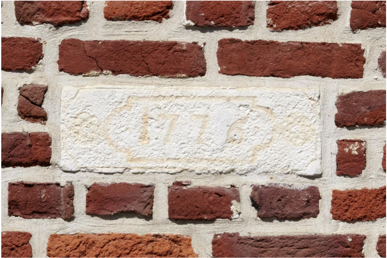
Date portée 1776 sur la face extérieure de la chapelle axiale sud.
