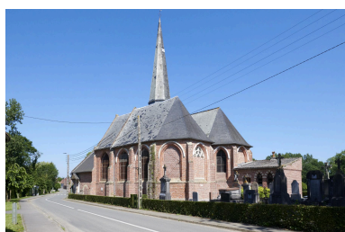
Vue de l'église depuis la rue Principale. Phot. Delphine Volto Jourdan IVR32_20245902438NUCA
