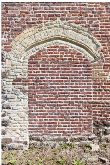
Ancienne entrée murée dans le bas-côté sud. Phot. Delphine Volto Jourdan IVR32_20245902440NUCA
