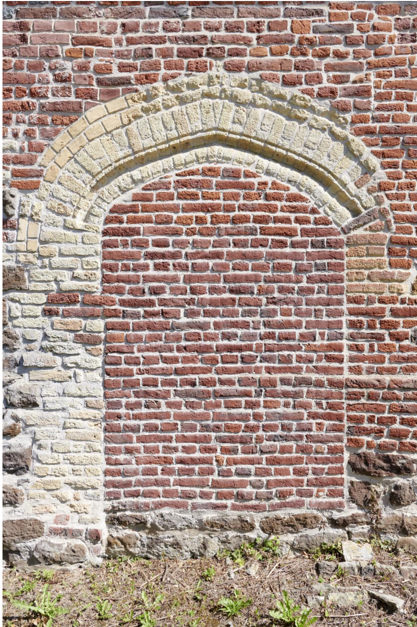
Ancienne entrée murée dans le bas-côté sud.
