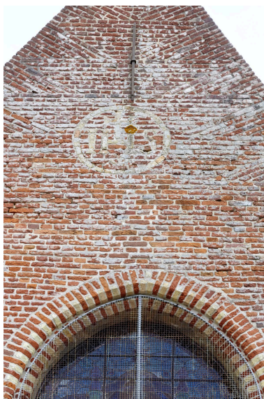
Détail de la façade, symbole IHS en brique jaune. Phot. Delphine Volto Jourdan IVR32_20245902496NUCA
