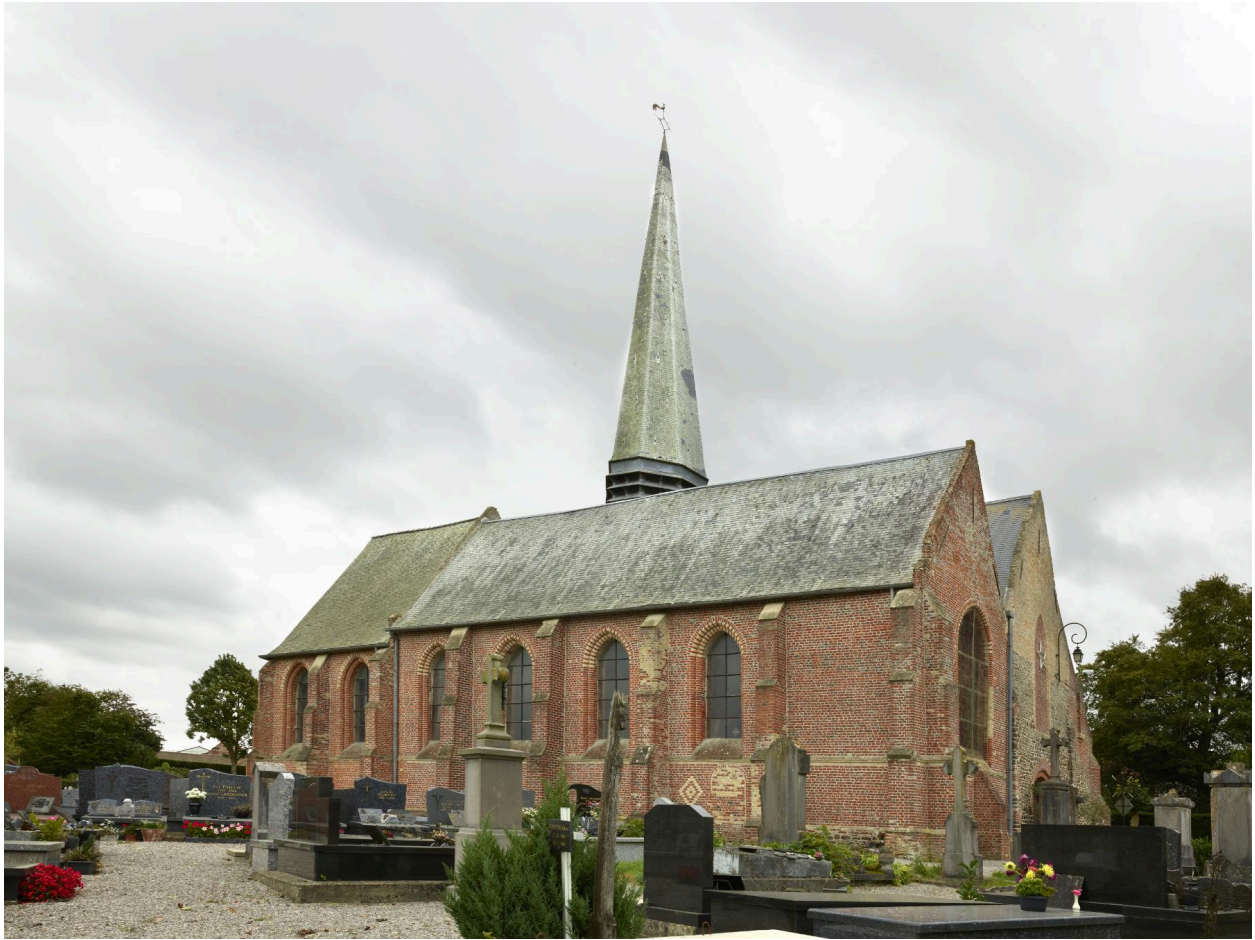
Bas-côté nord de l'église Saint-Omer.
