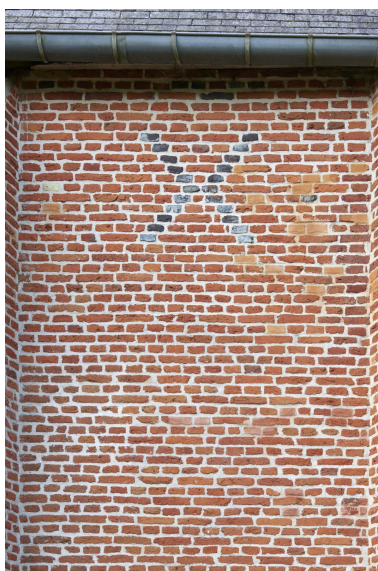
Croix de Saint-André réalisée en brique noire. Phot. Delphine Volto Jourdan IVR32_20245902458NUCA
