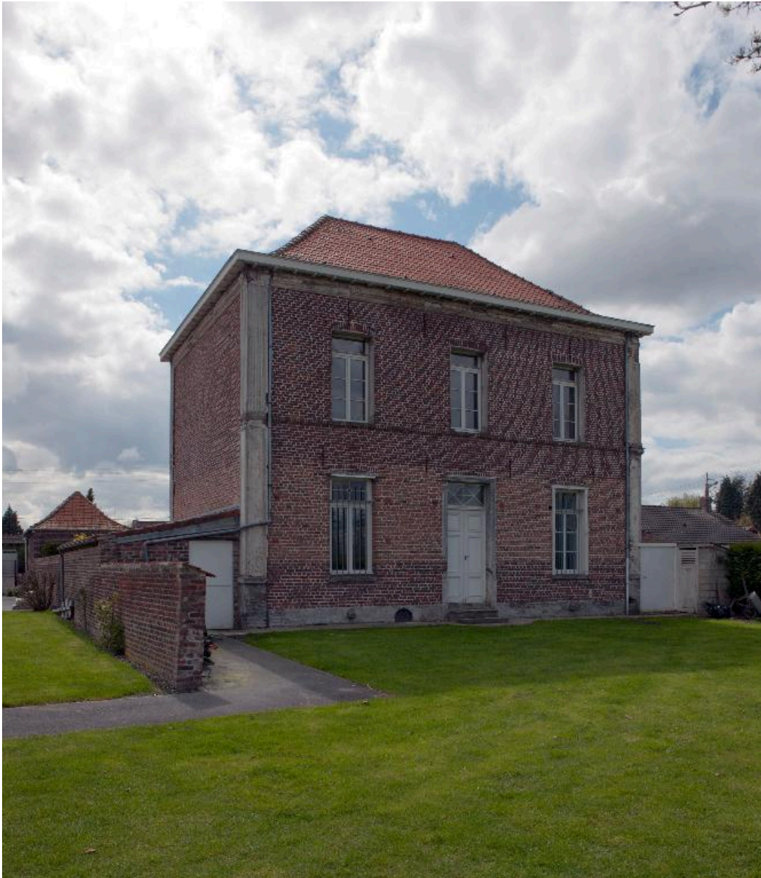
Elévation postérieure de la mairie, façade en brique non enduite et pilastres ioniques aux angles.
