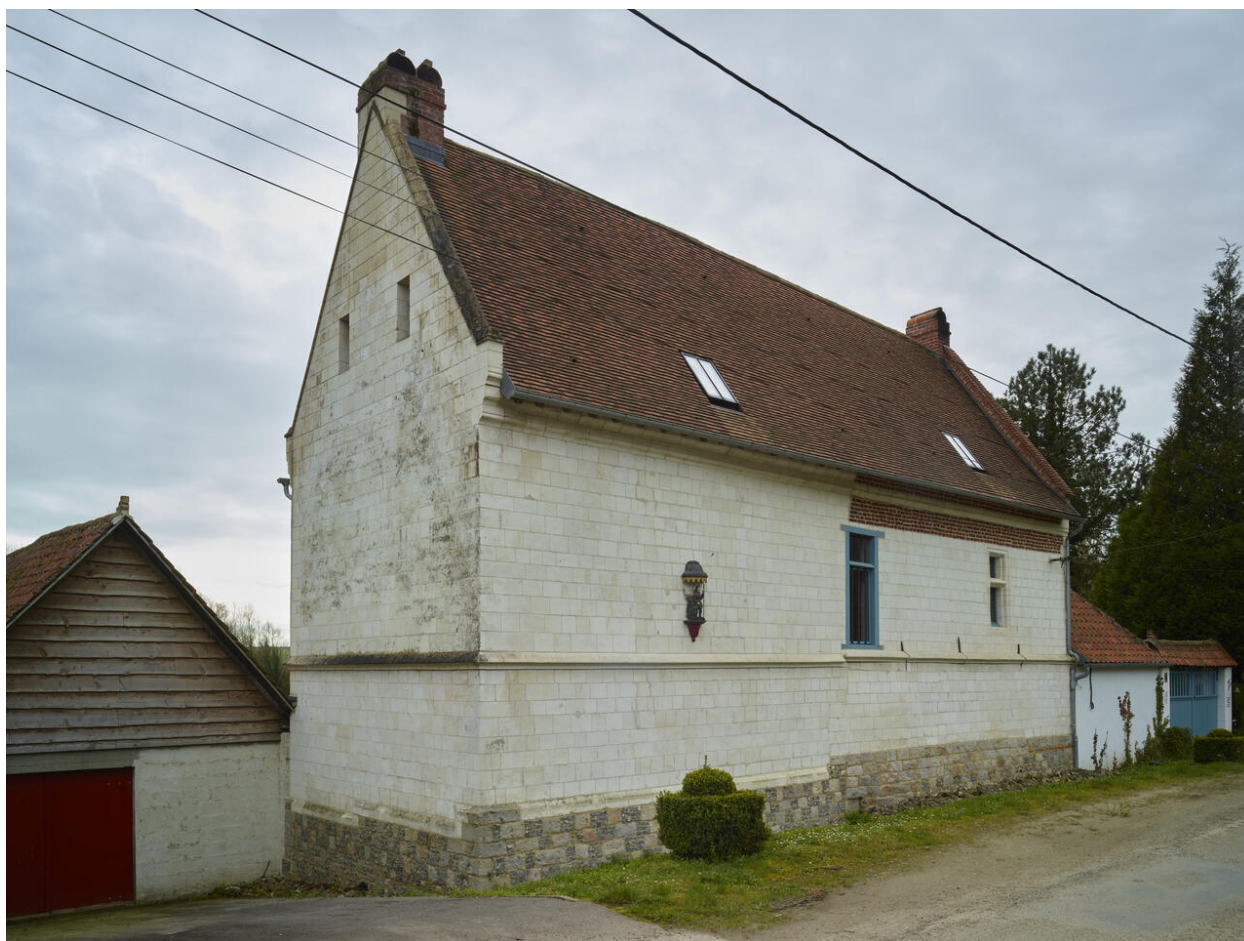
Vue générale de la façade antérieure du manoir donnant sur la chaussée avec son mur-pignon est.
