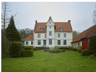
Vue générale de la façade postérieure du manoir donnant sur le jardin. Phot. Pierre Thibaut IVR32_20256200540NUCA
