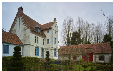
Vue générale du manoir avec son mur-pignon ouest à couteau picard. Phot. Pierre Thibaut IVR32_20256200546NUCA
