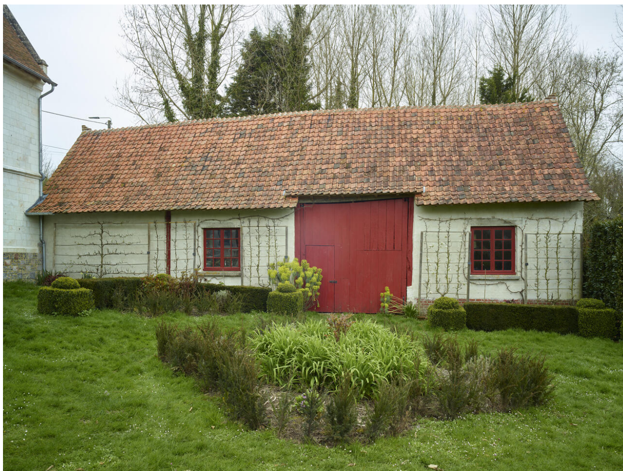
Vue générale des dépendances.
