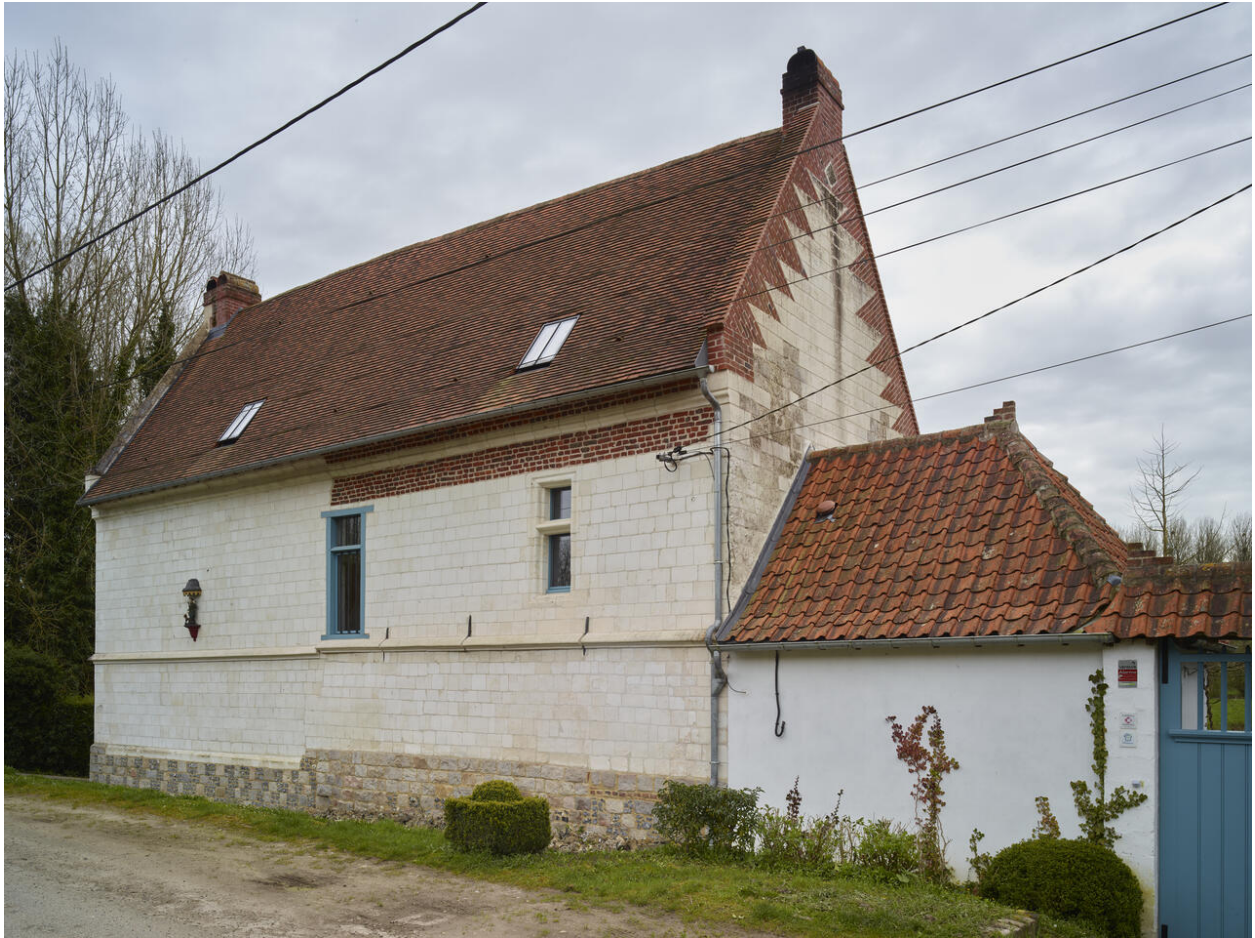
Vue générale de la façade antérieure du manoir donnant sur la chaussée.
