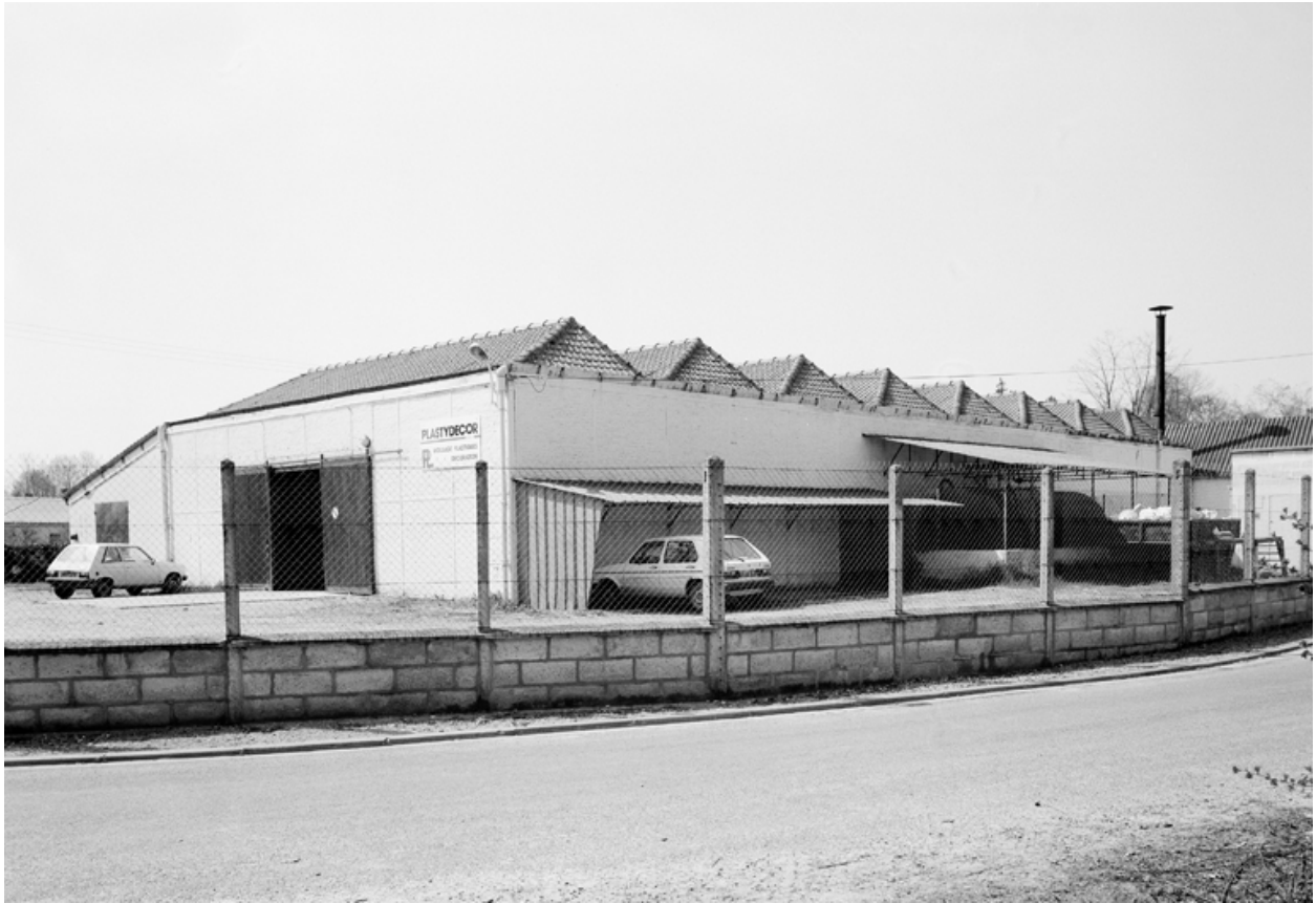
Atelier de fabrication, flanc sud-est, vue partielle.
