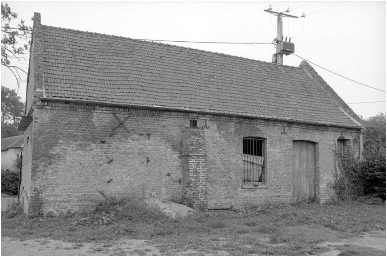
Remise, élévation postérieure.
