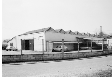
Atelier de fabrication, flanc sud-est, vue partielle. Phot. Thierry Lefébure IVR22_19888000621V
