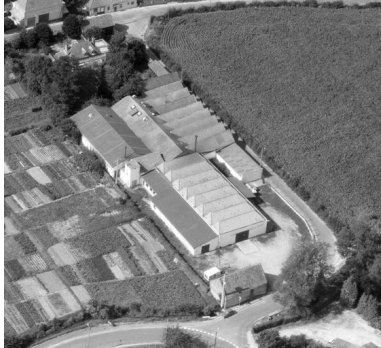
Vue aérienne, flanc sud. Phot. Phot'R IVR22_19888001380P
