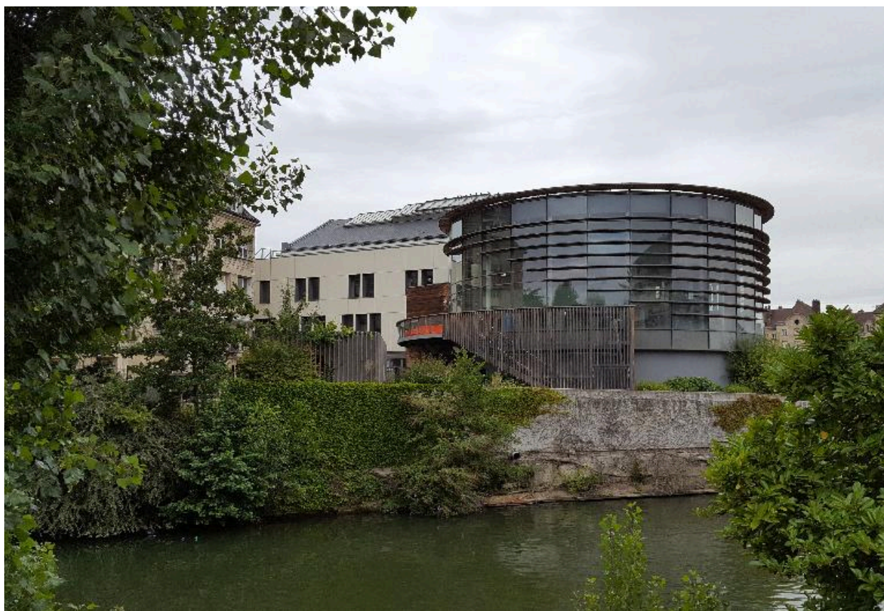
Vue de la façade sud, avec l'extension abritant les nouveaux bassins ludiques.
