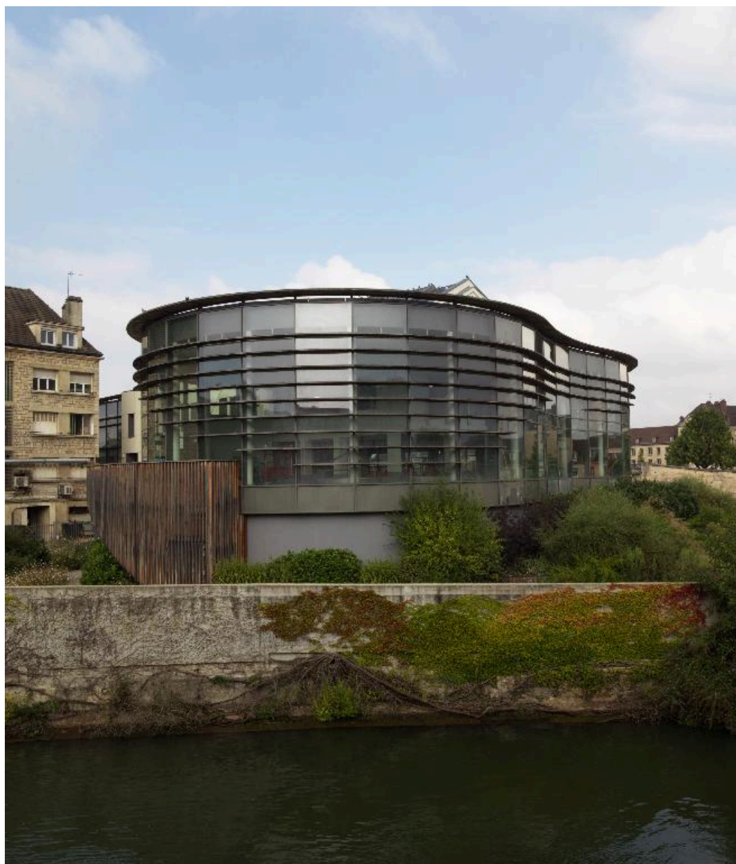
Façade sud, entièrement vitrée et abritant les nouveaux bassins ludiques.
