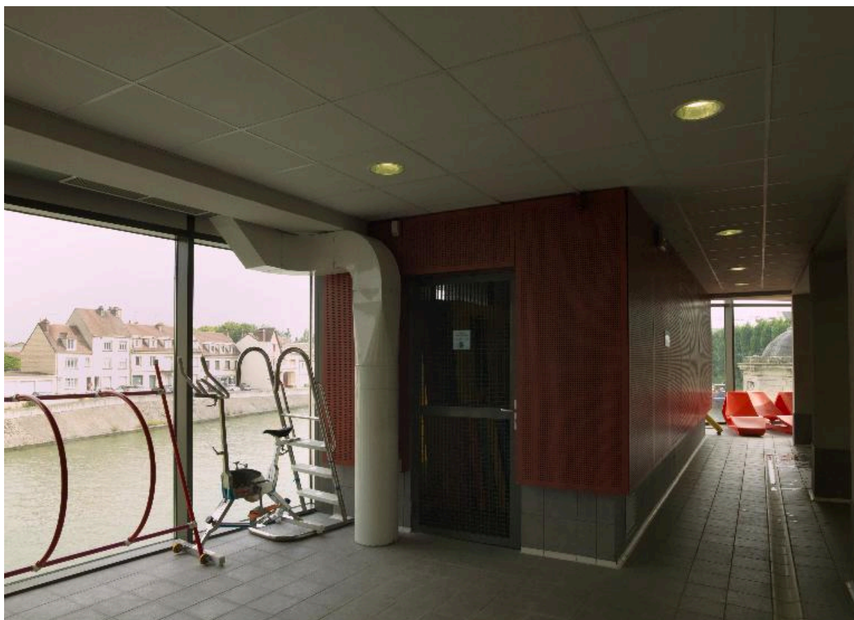
Ancien emplacement des douches (aujourd'hui local de rangement de matériel).
