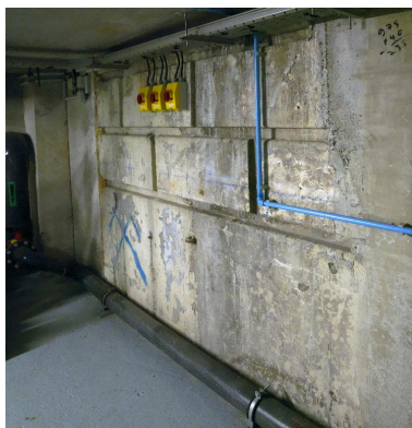
Vestiges de la structure en béton armé originelle (de 1926).
