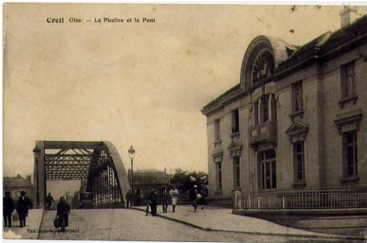
Façade de la piscine et le pont métallique de Creil. Carte postale, vers 1930 (coll. part.).
