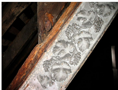
Linçoir de la charpente des combles sculpté de feuilles de vignes et de grappes de raisin. Phot. Clarisse Lorieux IVR22_20086005183NUCA
