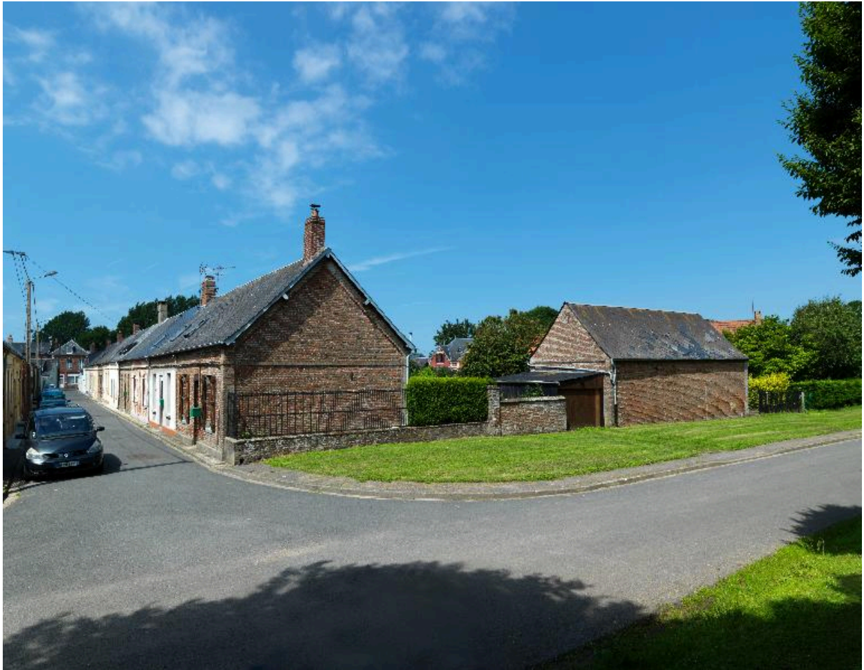
Vue de la cité Hurtel, depuis la rue Achille-Pruvost.
