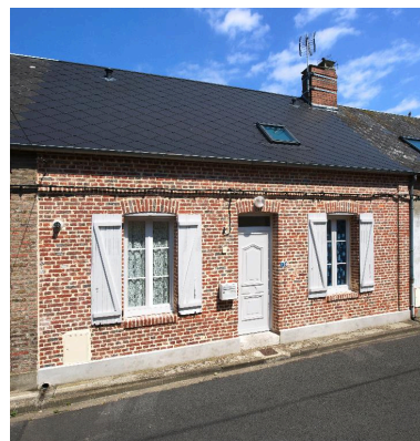
Vue d'un logement, n °19 de la cité Hurtel. Phot. Thierry Lefébure IVR22_20148000428NUC2AQ
