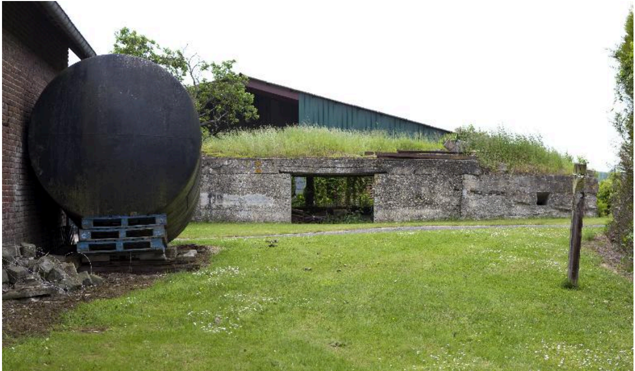
Vue de l'édifice vers le nord-est. Au centre l'accès à la chambre de tir, à droite la soute à munitions
