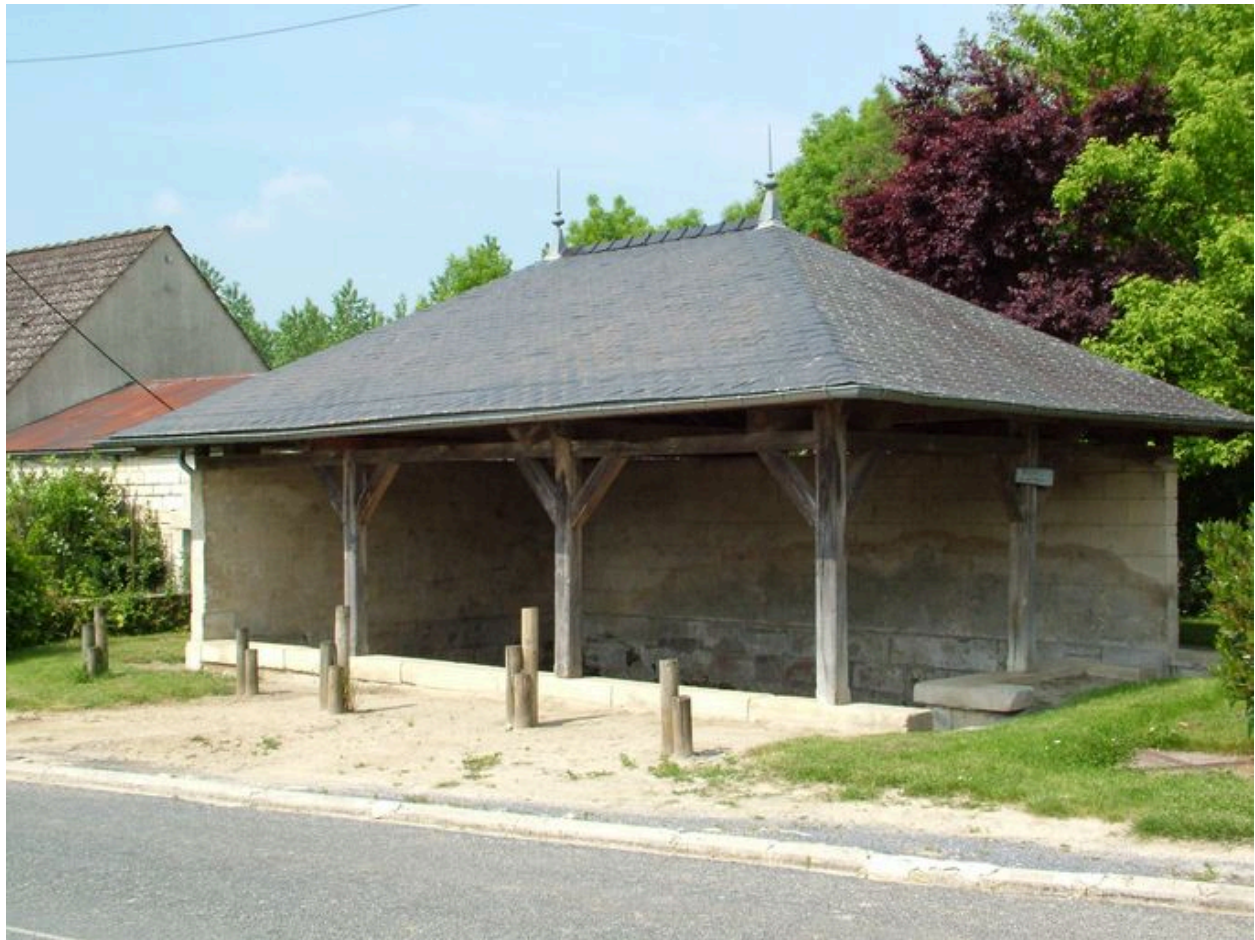
Vue générale du lavoir de Colligis-Crandelain.
