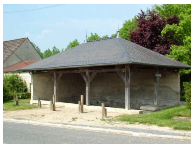
Vue générale du lavoir de Colligis-Crandelain.
