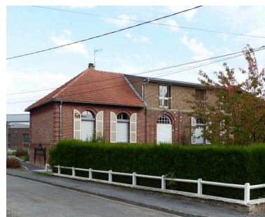
L'ancien hospice, vue depuis la rue Sainte-Radegonde.
