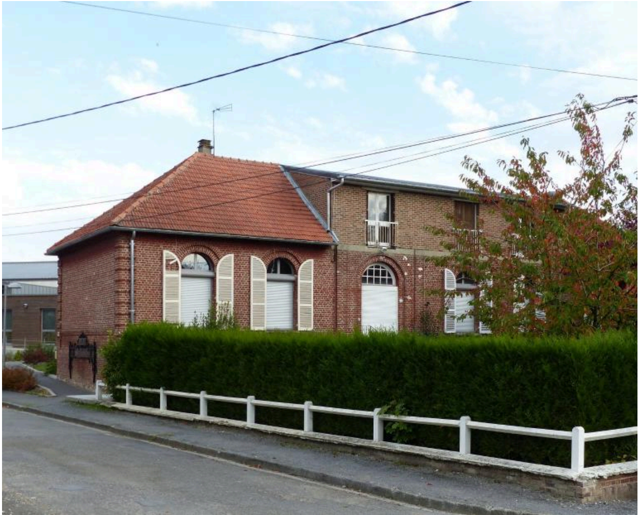
L'ancien hospice, vue depuis la rue Sainte-Radegonde.
