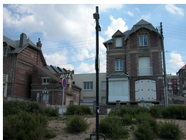
Vue d'ensemble de l'habitation et de l'ancienne remise à voiture hippomobile. Phot. Elisabeth Justome IVR22_20048001696NUCA
