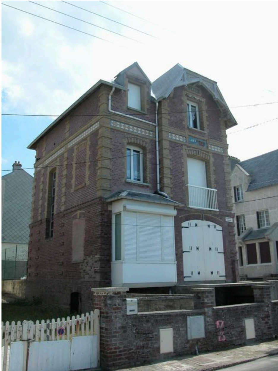
Vue de trois-quarts avec la façade latérale gauche.
