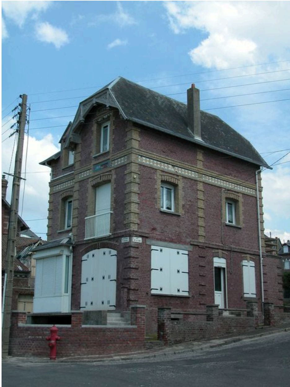
Vue de trois-quarts avec la façade latérale droite.
