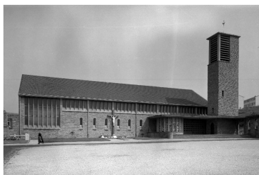
Vue générale extérieure. Phot. Philippe Caudroit IVR31_19826200390X
