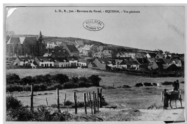
Façade sud de l'ancienne église actuellement détruite, carte postale (Boulogne, bibliothèque municipale).
