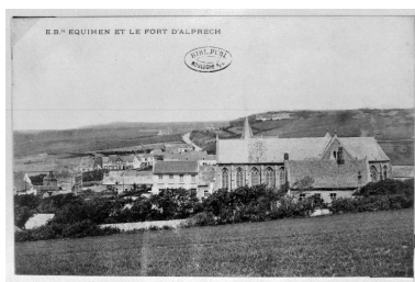
Façade sud de l'ancienne église actuellement détruite, carte postale (Boulogne, bibliothèque municipale). Phot. Jean-Michel Périn IVR31_19826200301XB
