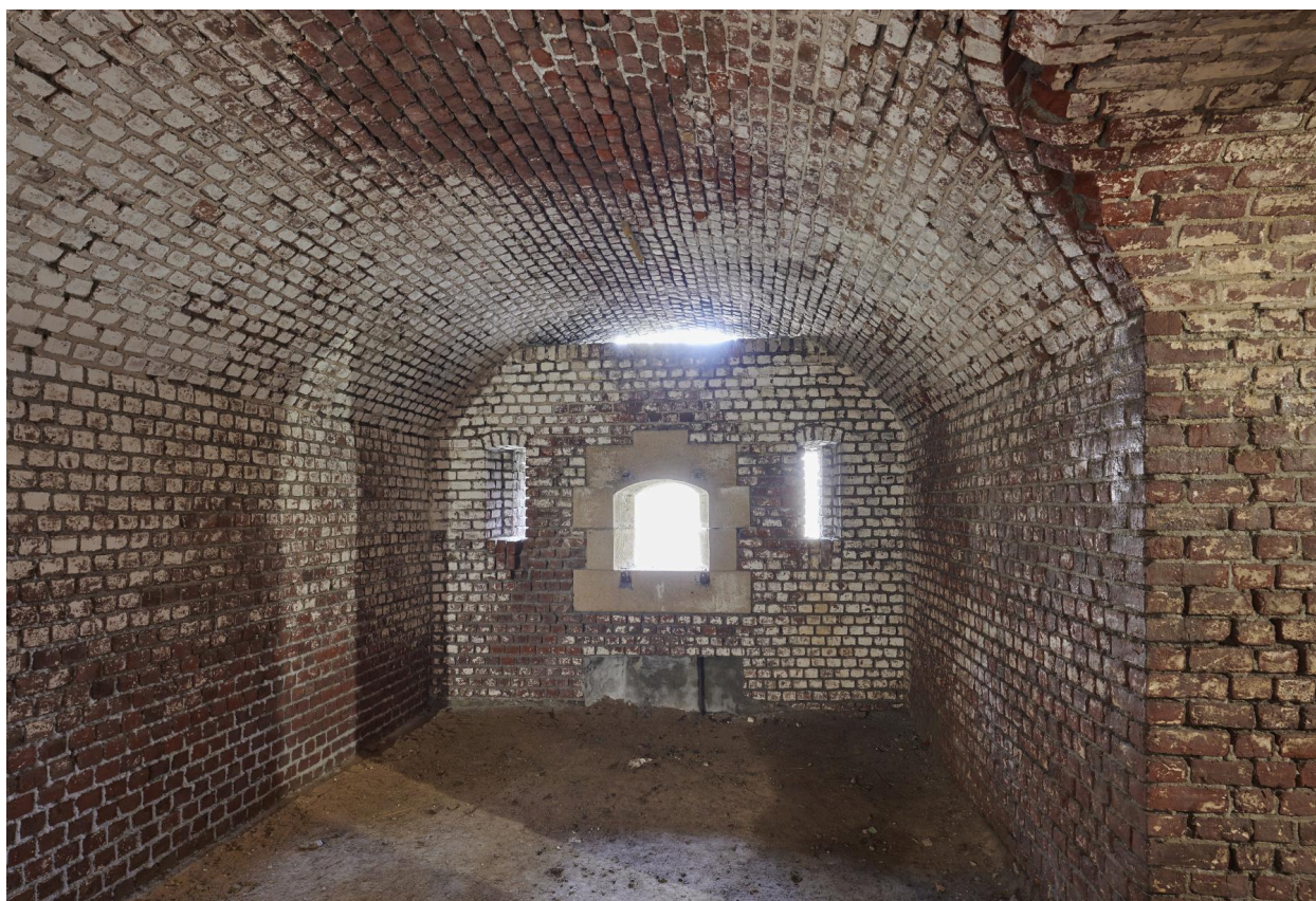
Seconde chambre de tir de la caponnière double.
