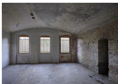
Sous-sol de caserne de gorge. Ancienne tisannerie. Phot. Pierre Thibaut IVR32_20235900062NUCA
