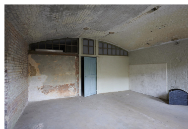
Sous-sol de caserne de gorge. Ancienne tisannerie. Phot. Pierre Thibaut IVR32_20235900064NUCA
