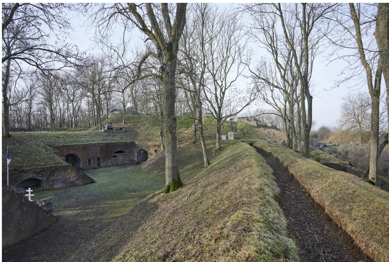
Vue générale depuis le chemin de ronde vers l'ouest, à gauche la cour est.
