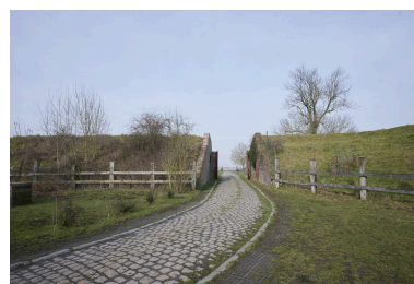
Chemin d'accès au fort, depuis le ravelin, vers le nord. Phot. Pierre Thibaut IVR32_20235900107NUCA
