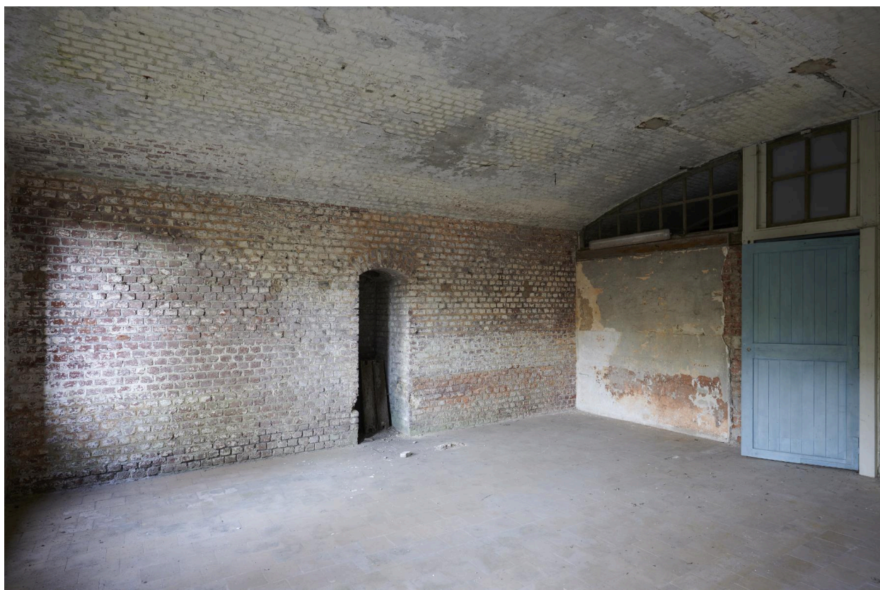
Sous-sol de caserne de gorge. Ancienne tisannerie.
