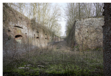
Galerie de fusillade et fossé est, vers le nord depuis la caponnière double. Phot. Pierre Thibaut
