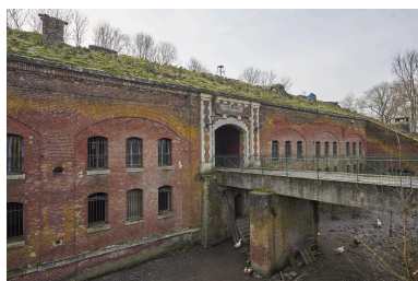
Élévation nord, caserne de gorge, pont dormant et (ancien) pont mobile, vers l'est. Phot. Pierre Thibaut IVR32_20235900110NUCA
