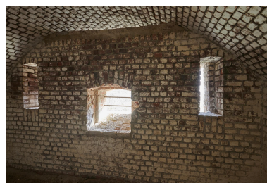
Caponnière double. Embrasures de tir dans le mur de masque. Phot. Pierre Thibaut IVR32_20235900094NUCA
