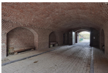
Passage couvert sous la caserne de gorge, vers le nord. Phot. Pierre Thibaut IVR32_20235900054NUCA
