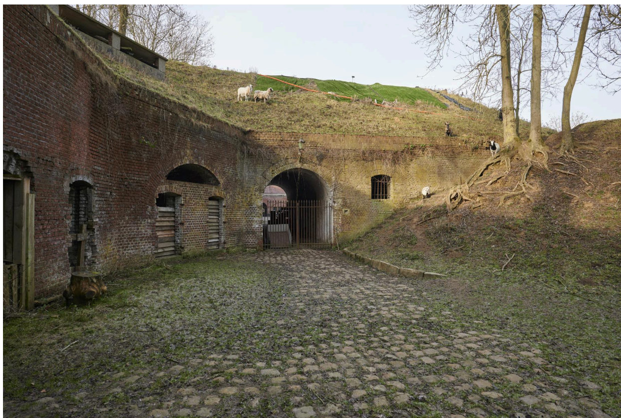
Accès à la cour centrale depuis la cour est.
