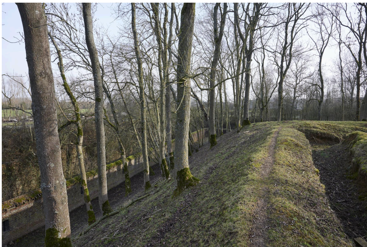
Fossé de gorge et contrescarpe depuis le chemin de ronde, vers l'est.
