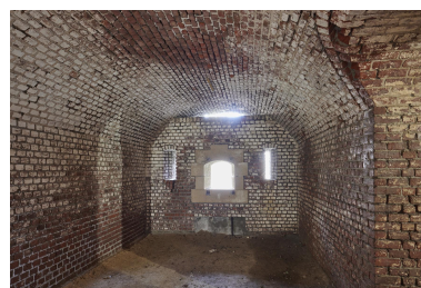
Seconde chambre de tir de la caponnière double. Phot. Pierre Thibaut IVR32_20235900098NUCA
