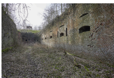
Depuis le fossé est : en face, la caponnière double, à droite les créneaux de fusillade. Phot. Pierre Thibaut IVR32_20235900105NUCA
