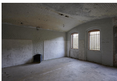
Sous-sol de caserne de gorge. Ancienne tisannerie. Phot. Pierre Thibaut IVR32_20235900063NUCA
