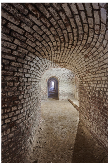
Couloir reliant les casemates de flanquement de la caponnière double. Phot. Pierre Thibaut IVR32_20235900093NUCA
