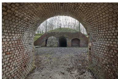
Couloir passant sous la partie est de la crête d'artillerie, en direction de la caponnière double. Au centre la descente de la caponnière.
