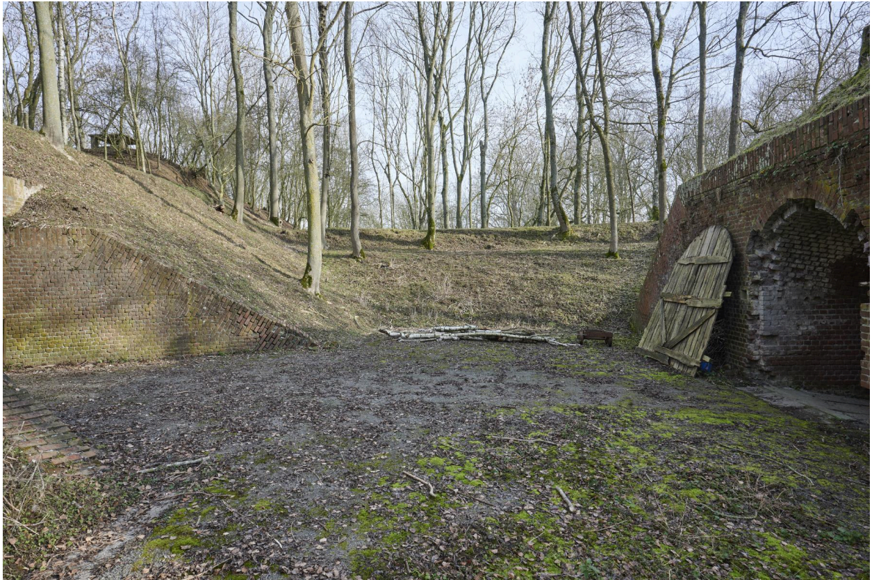
Cour sud-est. À gauche, l'entrée de la descente vers la caponnière double.
