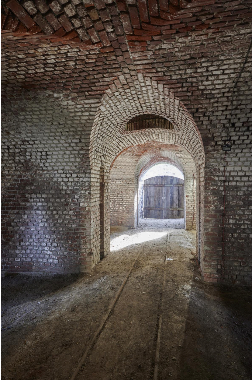
Sortie de descente de la caponnière double ouvrant sur le fossé de tête. Cheminée d'évacuation des fumées d'artillerie.
