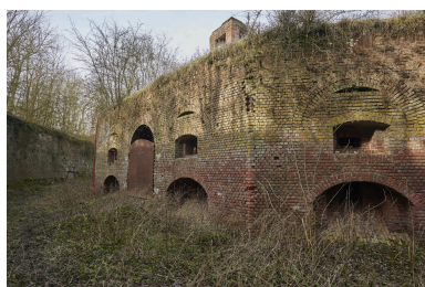
La caponnière double vers le sud-ouest. Phot. Pierre Thibaut
