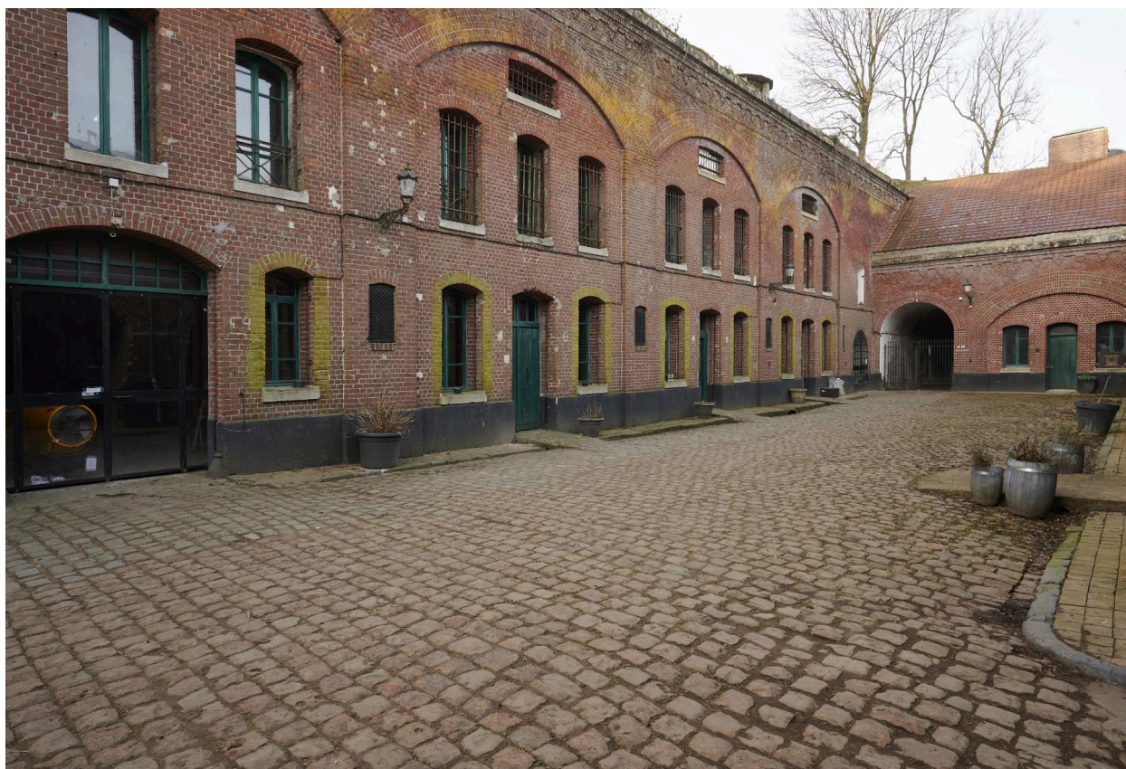
Élévation nord de la caserne centrale, vers l'est.
