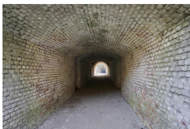
Couloir passant sous la partie est de crête d'artillerie, en direction de la caponnière double.
