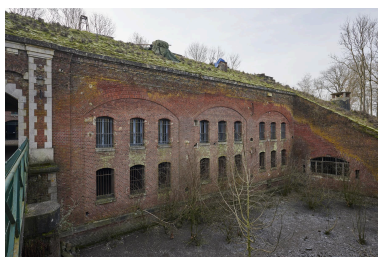
Élévation nord, caserne de gorge et batterie de flanquement ouest. Phot. Pierre Thibaut IVR32_20235900108NUCA
