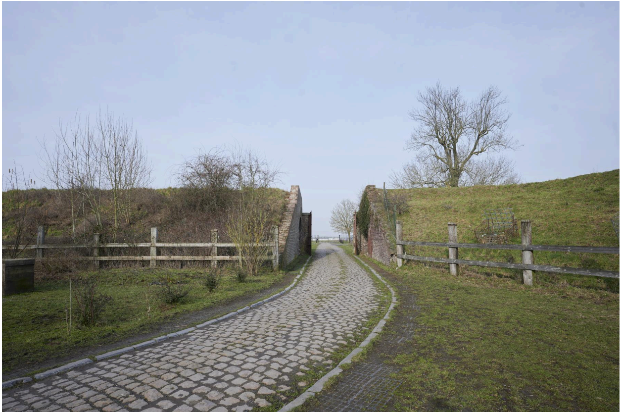
Chemin d'accès au fort, depuis le ravelin, vers le nord.
