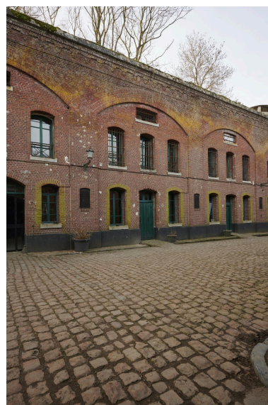
Deux travées de l'élévation nord de la caserne centrale, vers le sud-est. Phot. Pierre Thibaut IVR32_20235900057NUCA
