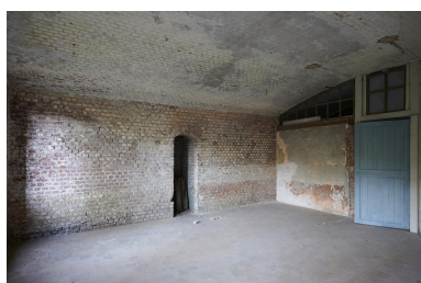
Sous-sol de caserne de gorge. Ancienne tisannerie. Phot. Pierre Thibaut IVR32_20235900065NUCA
