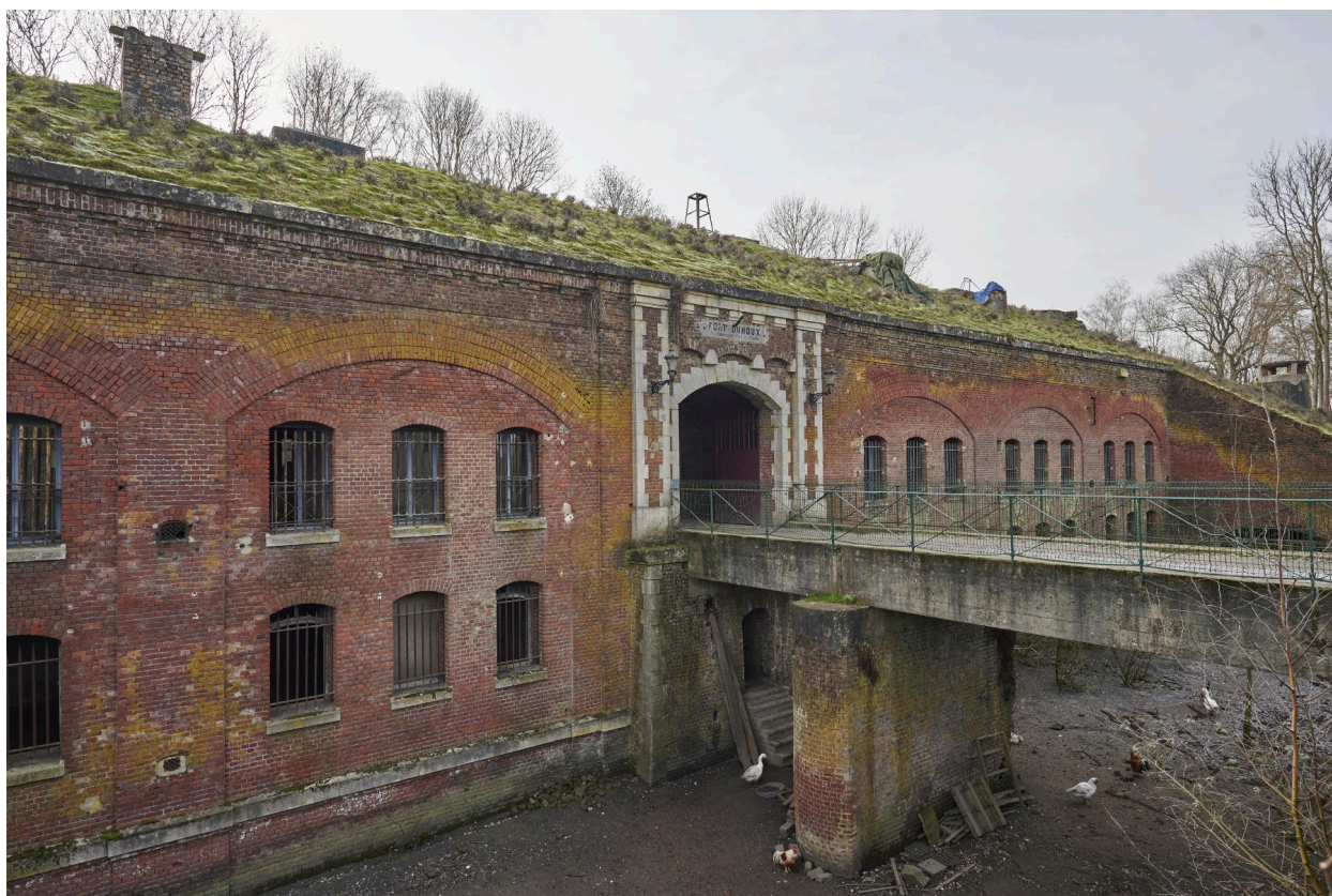
Élévation nord, caserne de gorge, pont dormant et (ancien) pont mobile, vers l'est.
