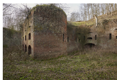
La caponnière double depuis le fossé est. Phot. Pierre Thibaut IVR32_20235900103NUCA
