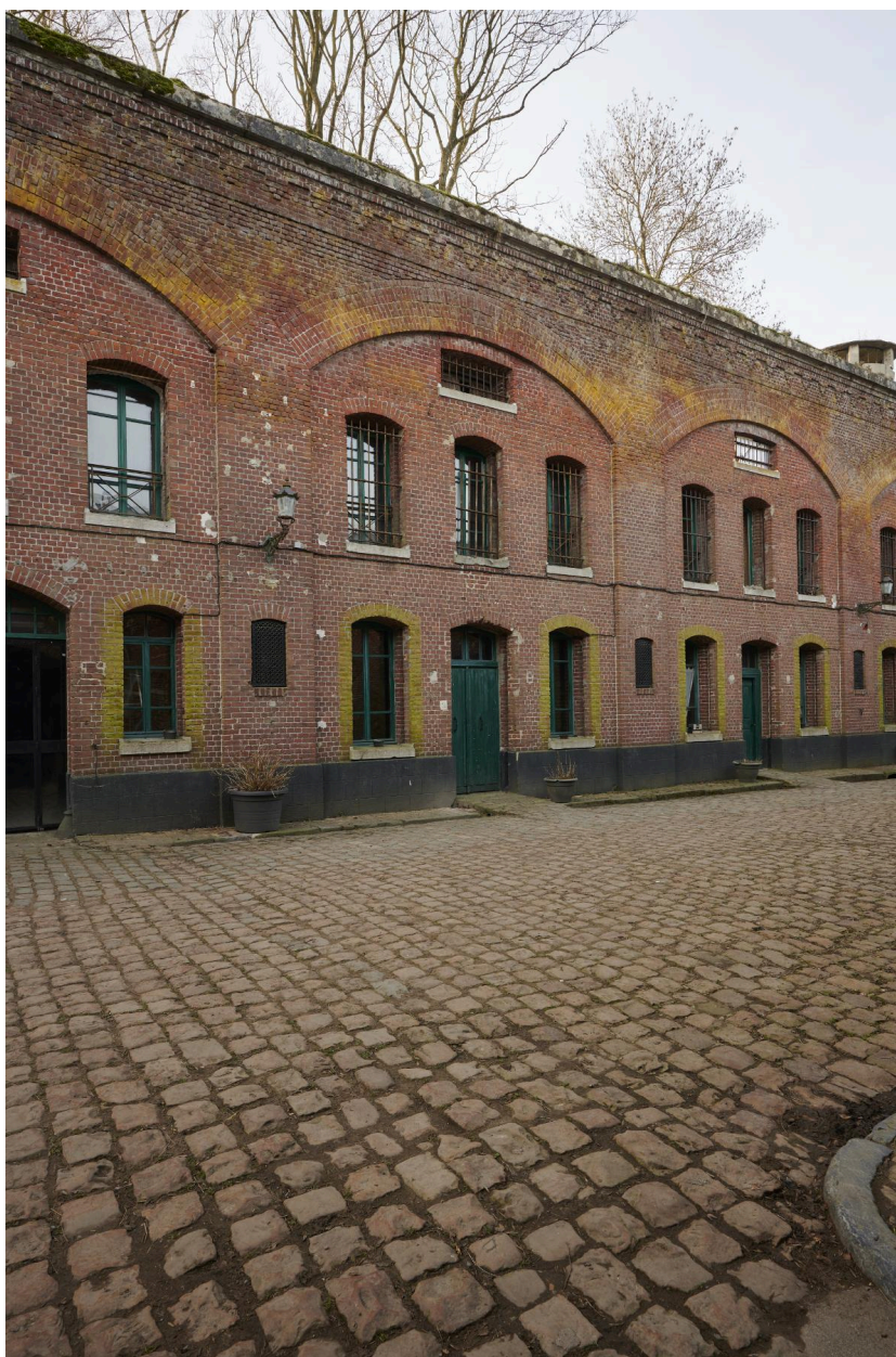
Deux travées de l'élévation nord de la caserne centrale, vers le sud-est.
