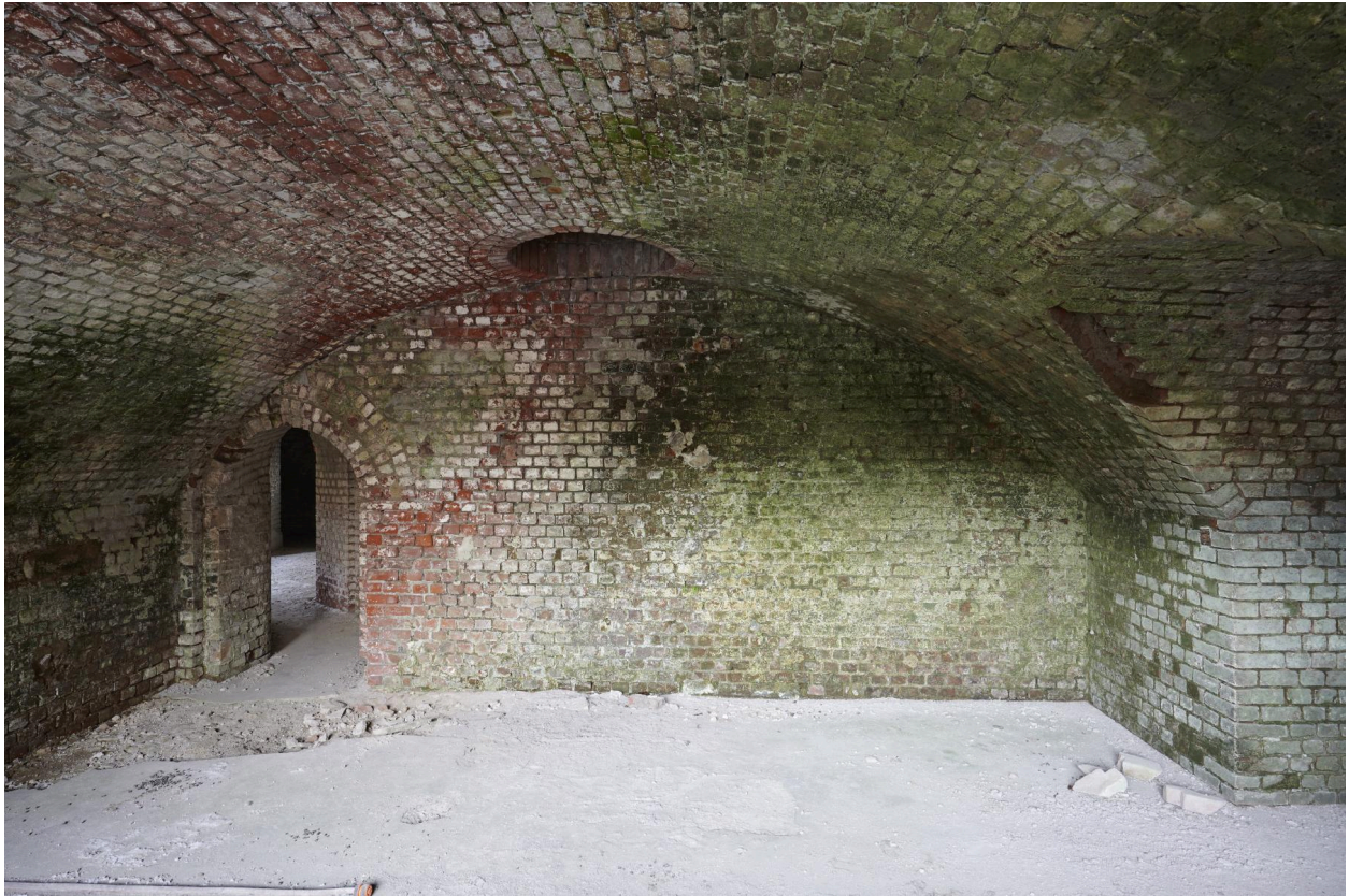
Sous-sol de caserne de gorge. Caserne de flanquement est, deuxième salle.
