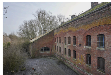
Élévation nord, caserne de gorge et batterie de flanquement ouest. Phot. Pierre Thibaut IVR32_20235900111NUCA
