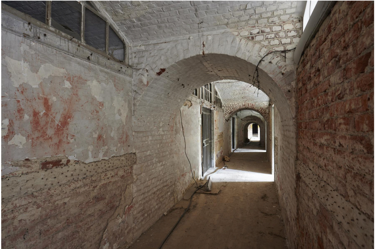
Couloir du sous-sol de caserne de gorge.
