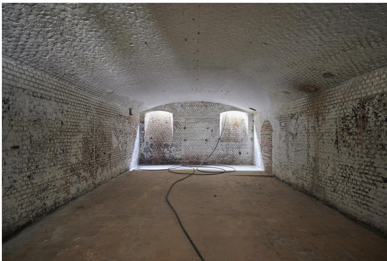
Sous-sol de caserne de gorge. Ancien magasin du génie.
