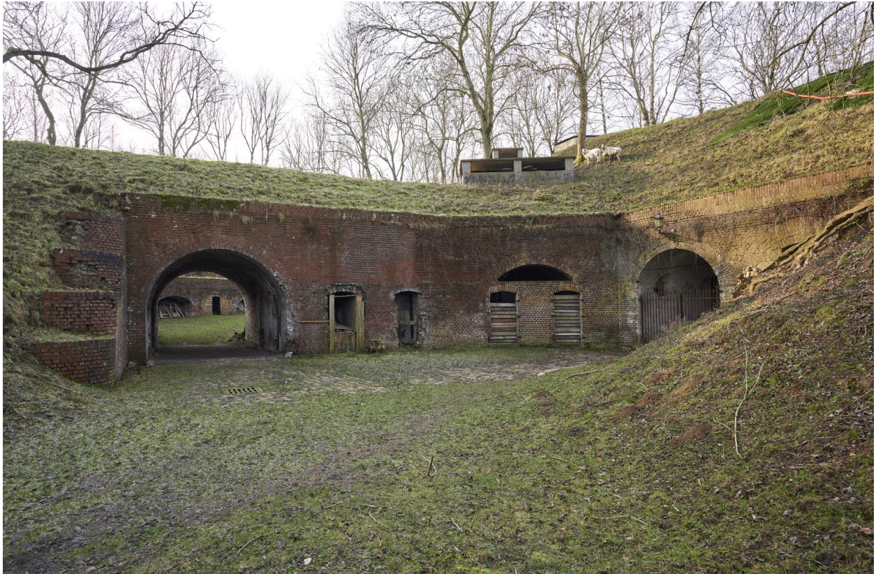
Cour est. À gauche, l'accès à la crête d'artillerie, à droite, passage menant à la cour centrale.
