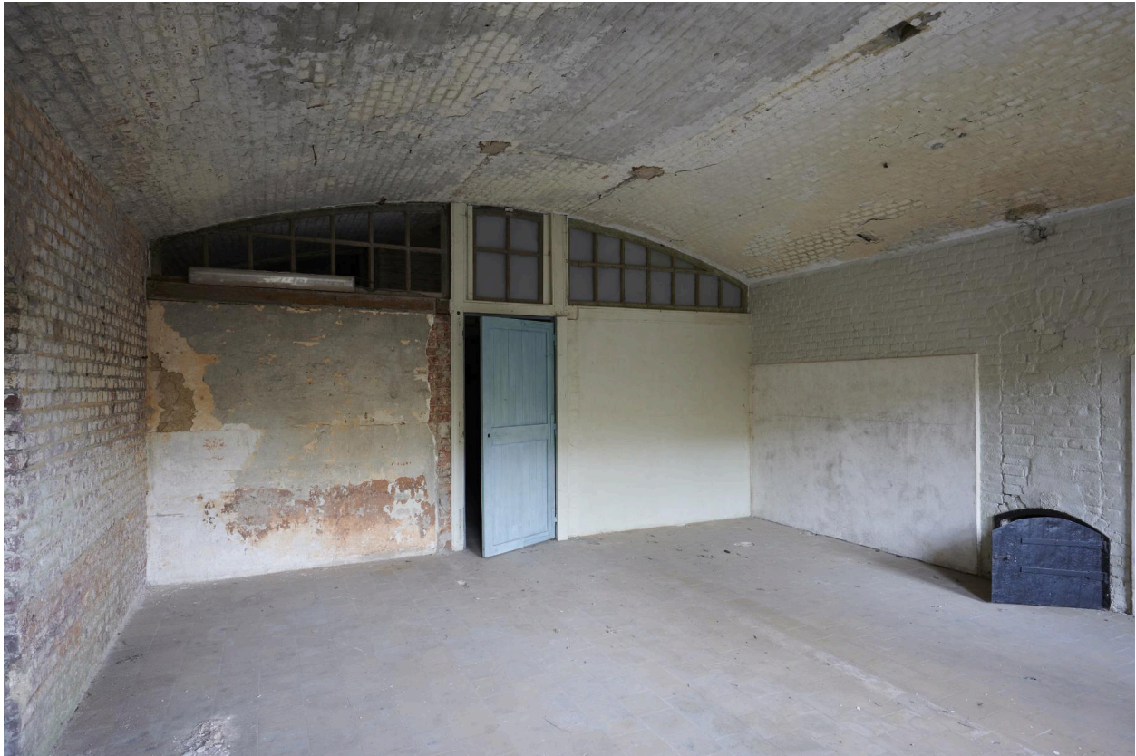
Sous-sol de caserne de gorge. Ancienne tisannerie.
