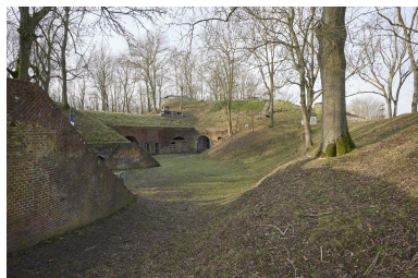
Vue générale de la cour est, vers l'est. Au centre, tunnel d'accès à la cour centrale.
