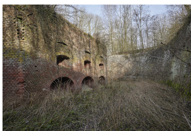
À gauche la caponnière double, vers le nord-est. Phot. Pierre Thibaut
