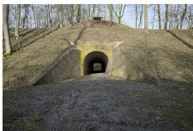
Sortie du couloir passant sous la partie est de crête d'artillerie et menant à la caponnière double.
