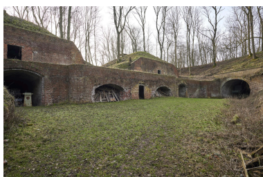
Partie est de la crête d'artillerie, vers le sud. Au centre, entre les deux casernes, la banquette de tir.
