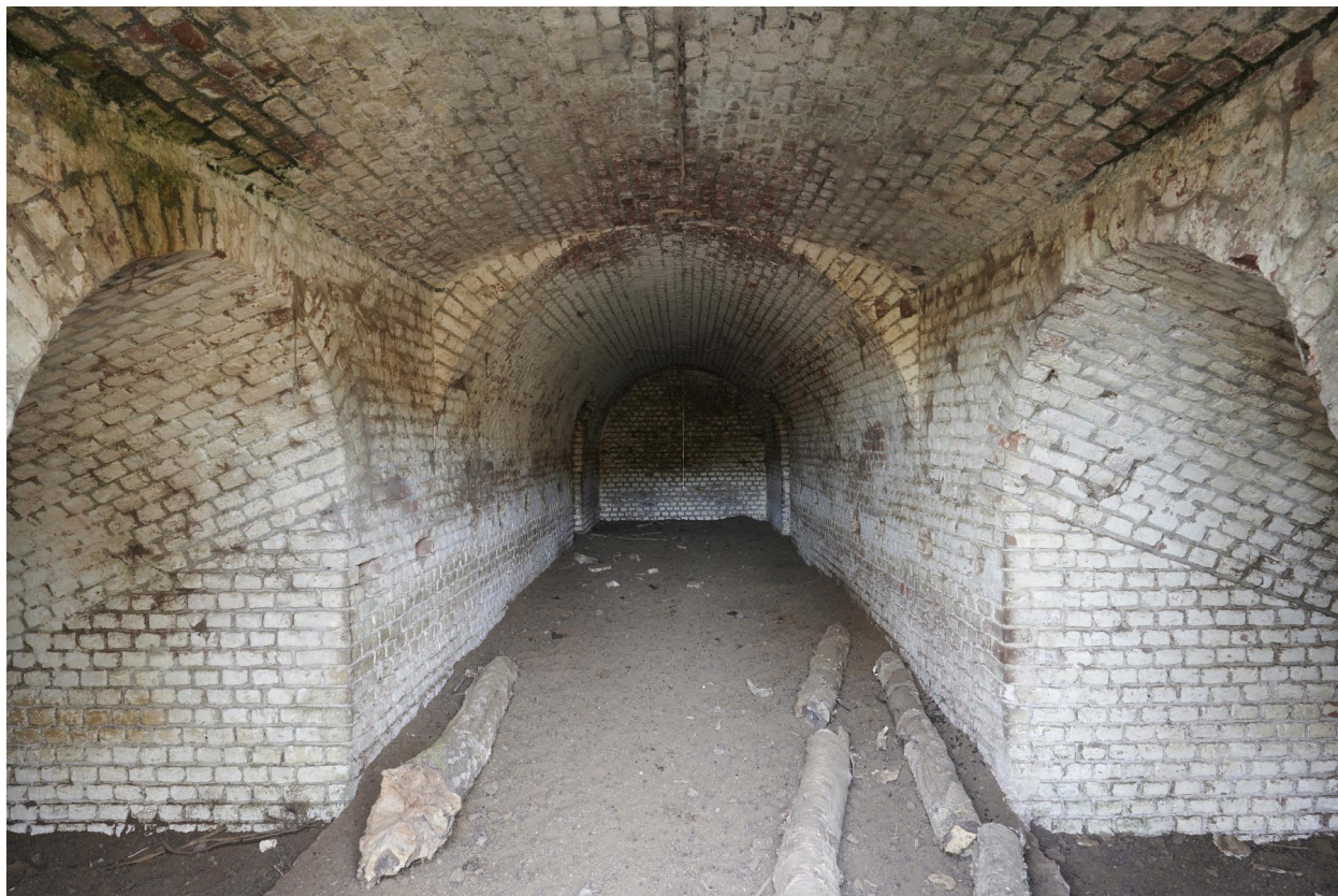
Vue intérieure d'une caserne située sur la partie est de la crête d'artillerie.
