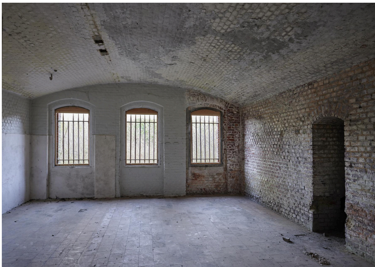
Sous-sol de caserne de gorge. Ancienne tisannerie.
