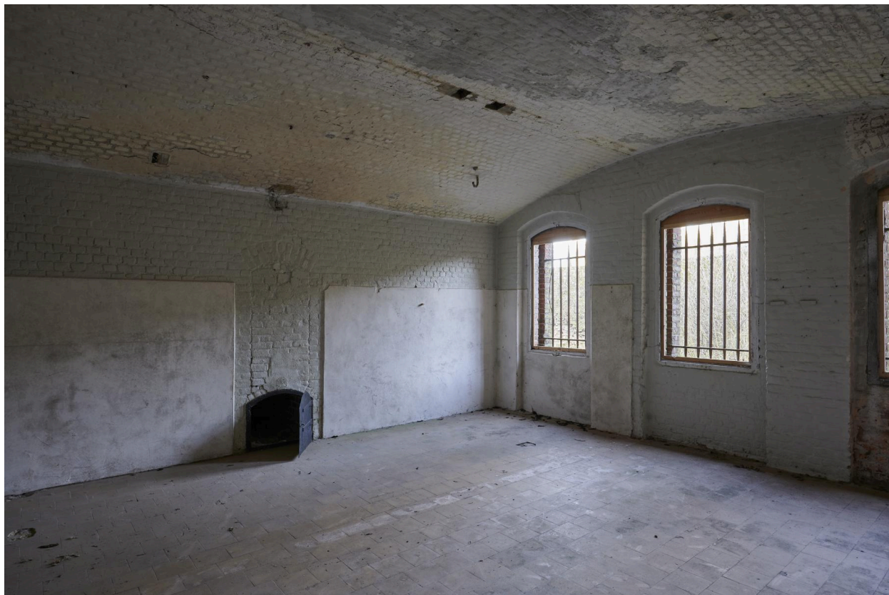
Sous-sol de caserne de gorge. Ancienne tisannerie.
