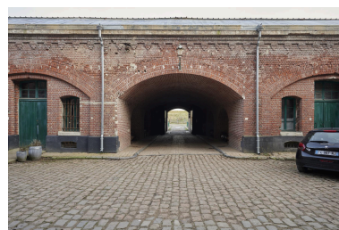
Passage couvert sous la caserne de gorge depuis la cour centrale, vers le nord. Phot. Pierre Thibaut IVR32_20235900053NUCA
