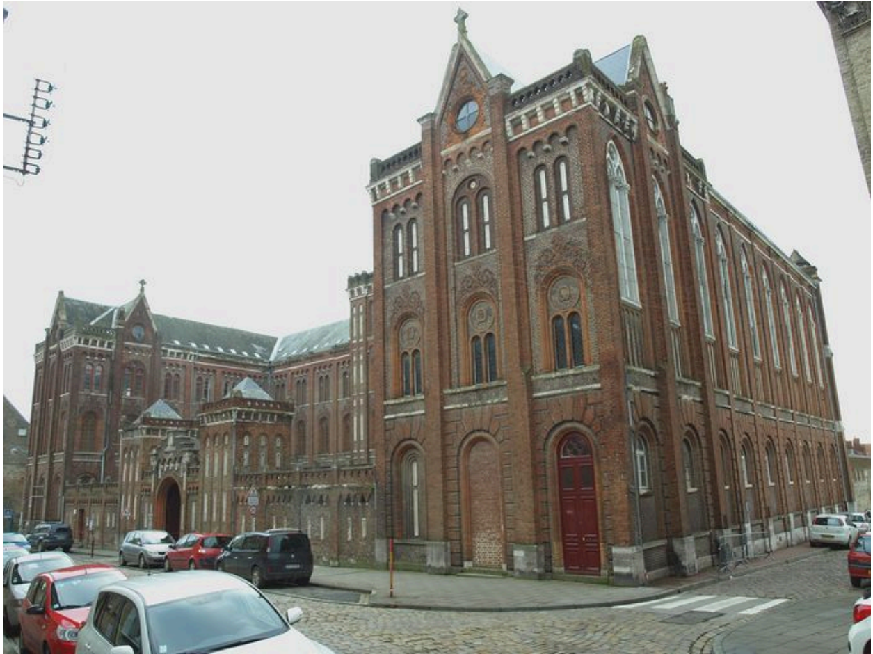
Façade sur rue : vue générale
