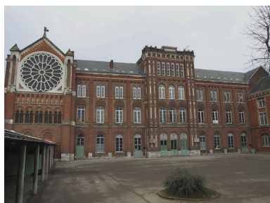
Façade sur cour : vue générale Phot. Bruno Decrock IVR31_20106208263NUCA
