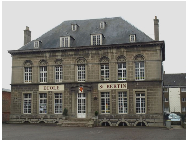
Le château (école primaire) : vue générale Phot. Bruno Decrock IVR31_20106208268NUCA
