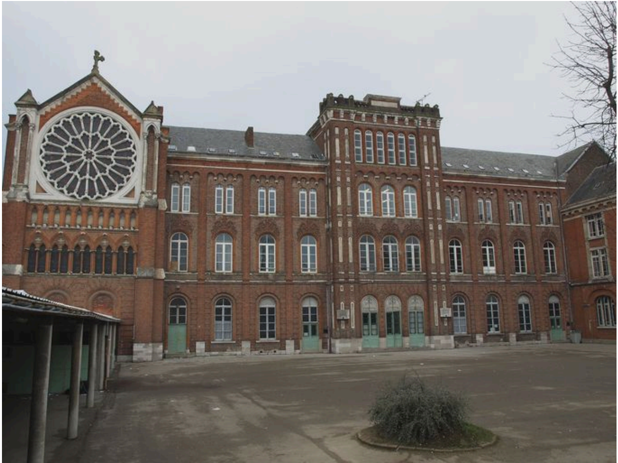
Façade sur cour : vue générale
