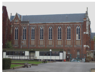
Chapelle : vue latérale Phot. Bruno Decrock IVR31_20106208265NUCA
