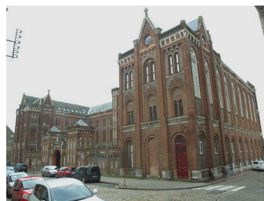
Façade sur rue : vue générale Phot. Bruno Decrock IVR31_20106208262NUCA
