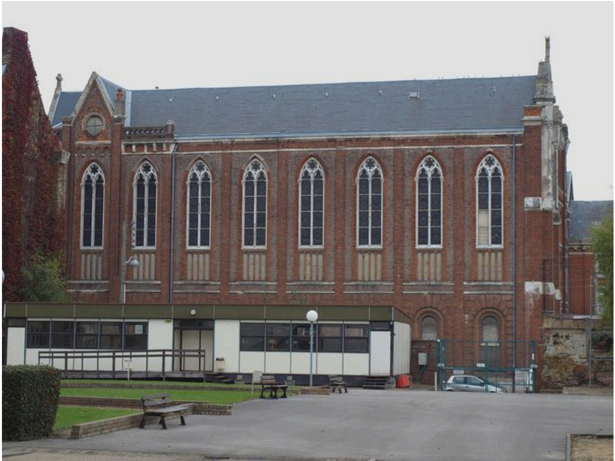
Chapelle : vue latérale
