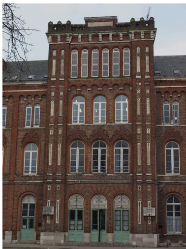
Pavillon central, façade sur cour Phot. Bruno Decrock IVR31_20106208264NUCA
