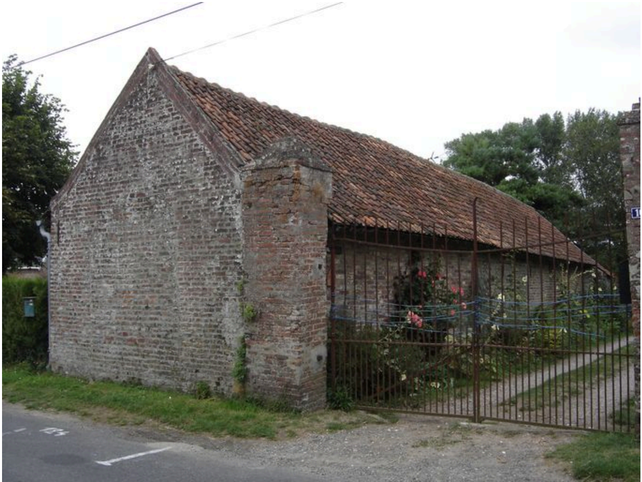
Vue postérieure des dépendances.
