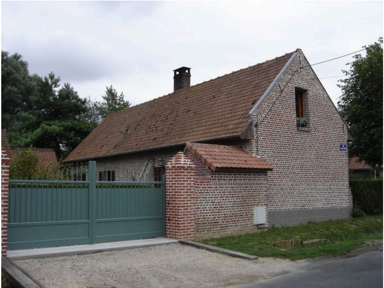
Vue postérieure du logis.
