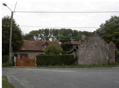
Vue générale. Phot. Inès Guérin IVR22_20068005070NUCA
