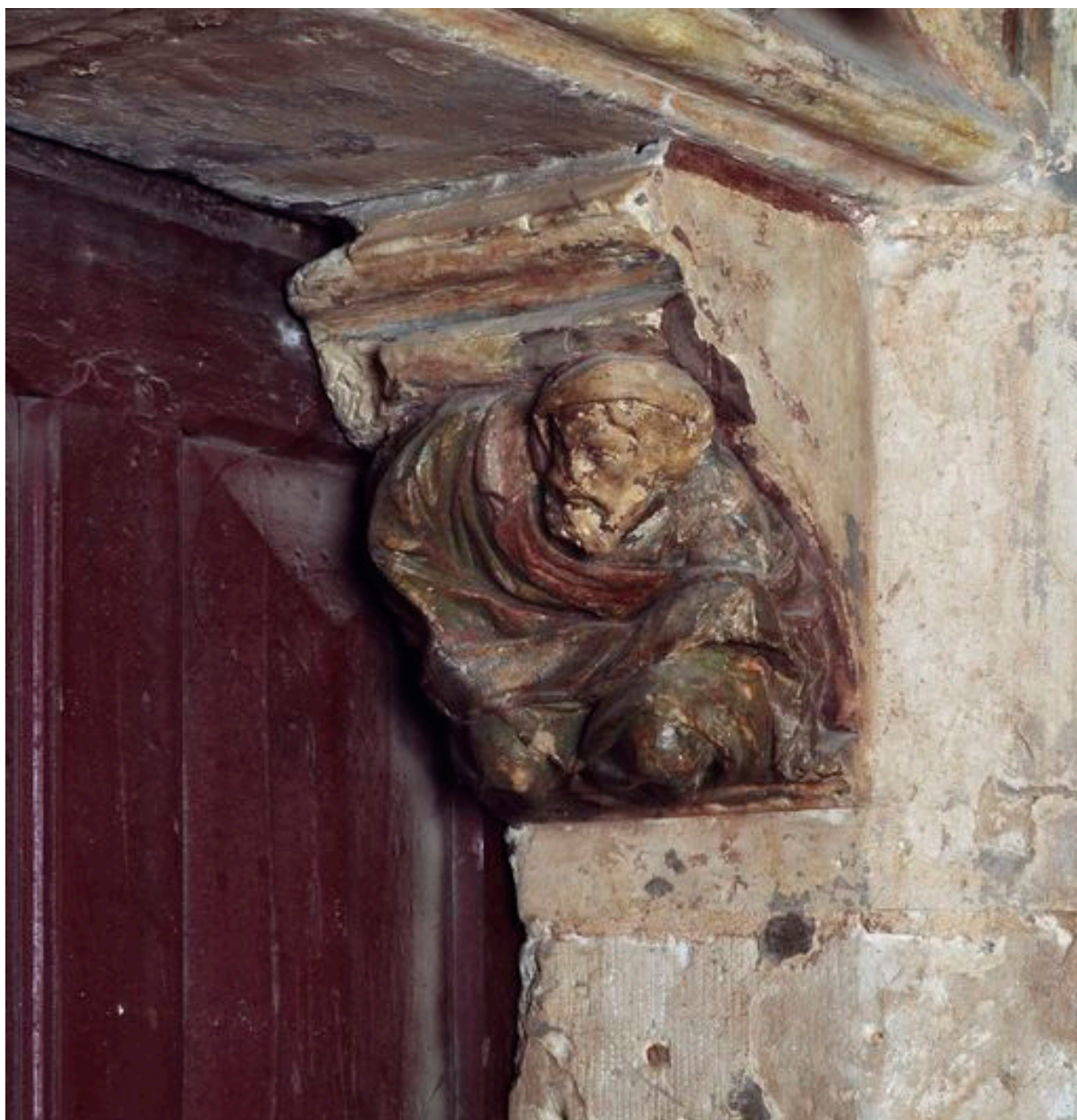
Décor du corbeau droit, après restauration.
