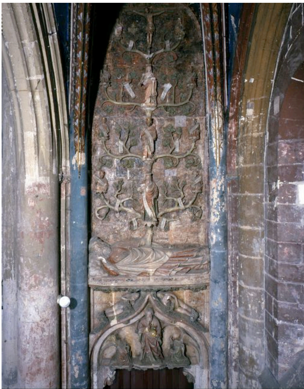
Vue de l'arbre de Jessé, avant restauration.
