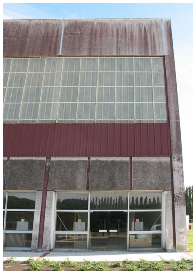
Détail d'une travée de la façade nord.
